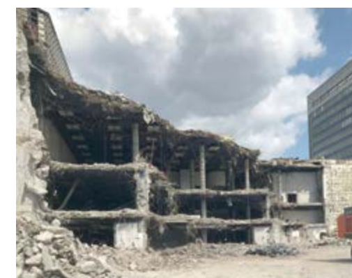
Proces búrání pílavej fasády, foto archiv
