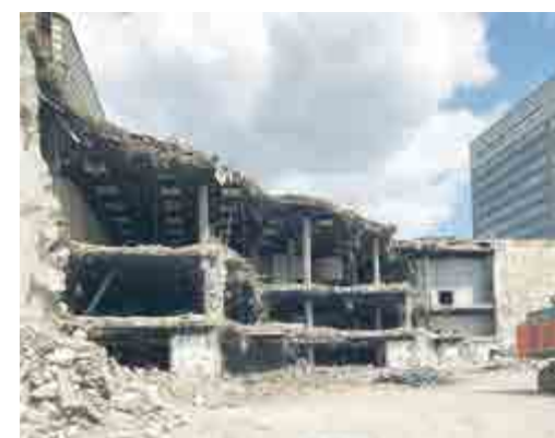
Proces búrania píllovej fasády, foto archiv
