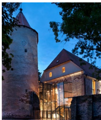
a) vstupní západní průčelí
