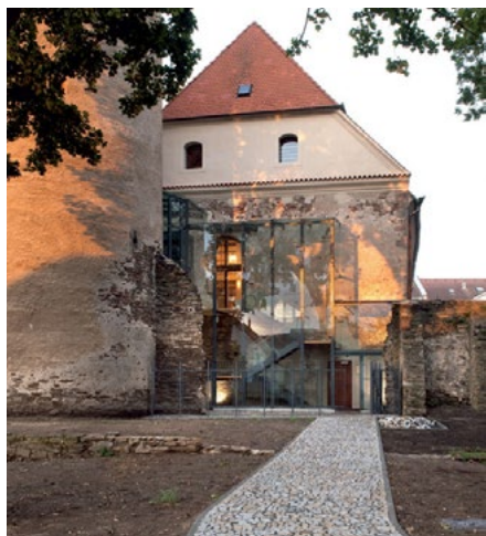
Západní vstupní průčelí po rekonstrukci v roce 2010 3
