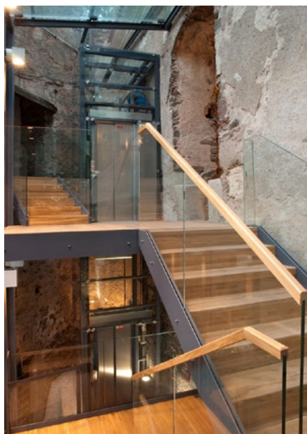
Po rekonstrukci 2010, prosklený vstup v západní části s bezbariérovým přístupem 7
