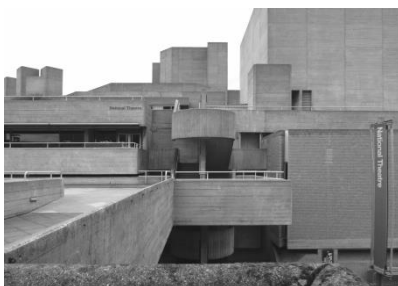
Obr. č. 3 – Exteriér
