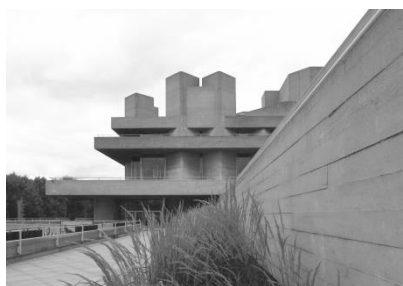
Obr. č. 2 – Exteriér
