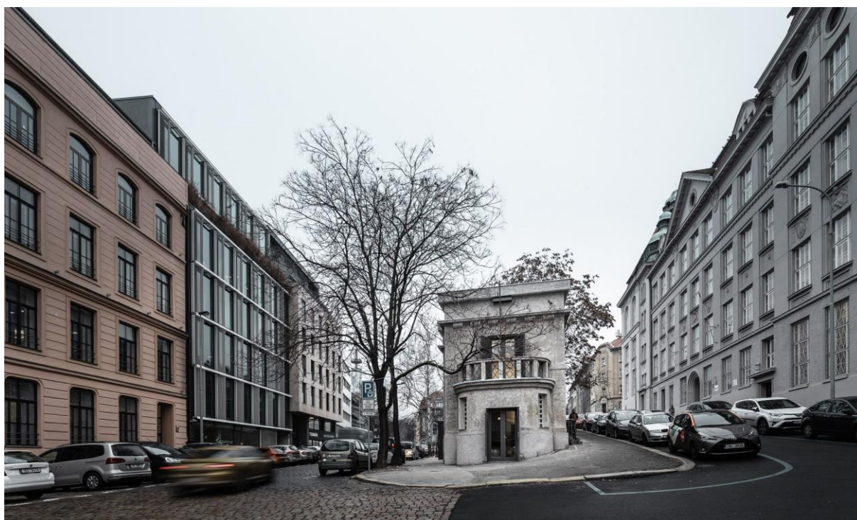
Pohled na trafostanici z ulice Kováků, Praha 2020, foto Andrea Thiel Lhotáková
