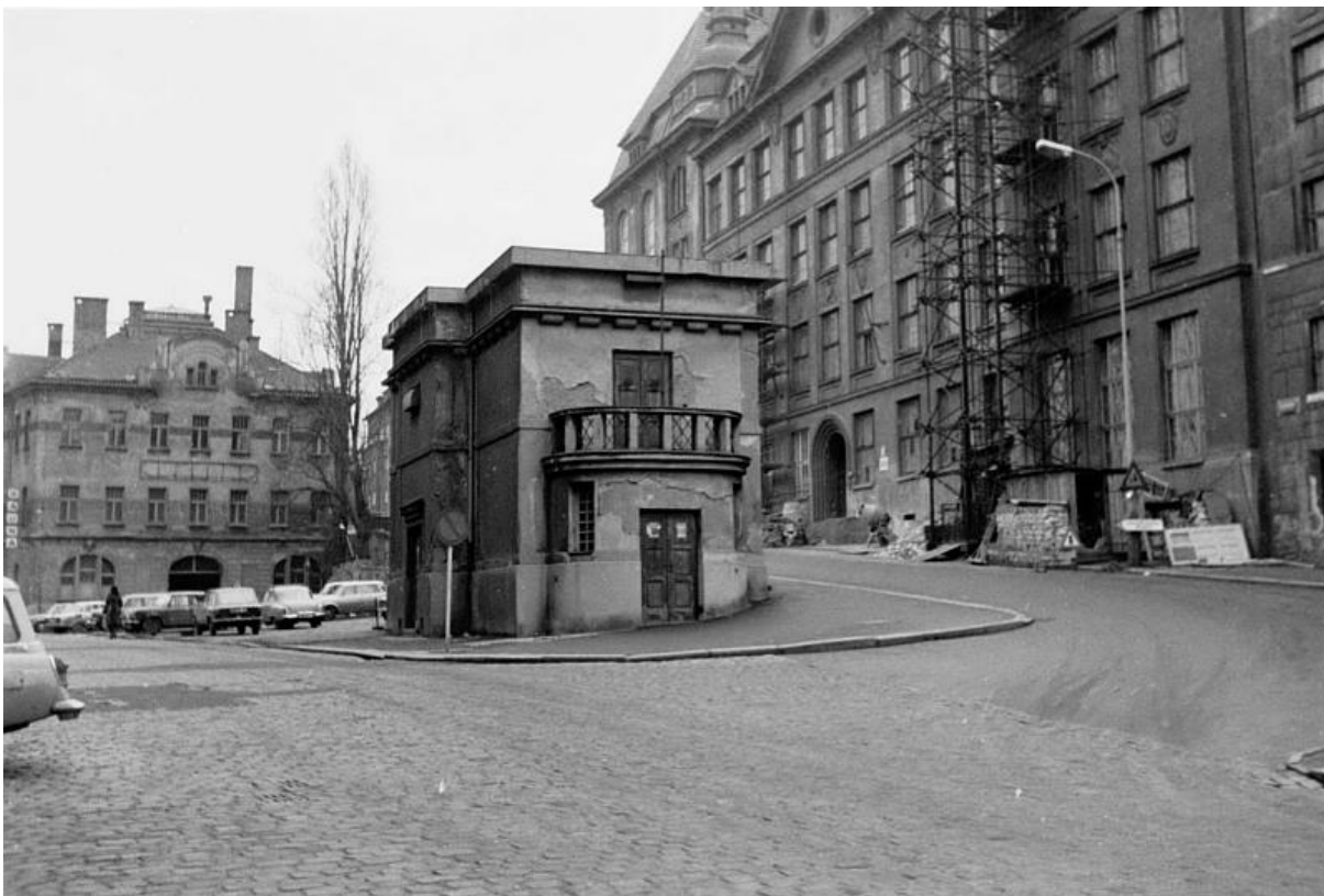
Pohled na trafostanici z ulice Kováků s bývalou masnou tržnicí v pozadí, Praha konec 60. let 20. st., foto Vlastimil Novotný
