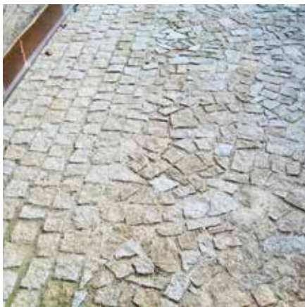
malá štípaná dlažba v parteru malá kostka u budov a rozhraní
