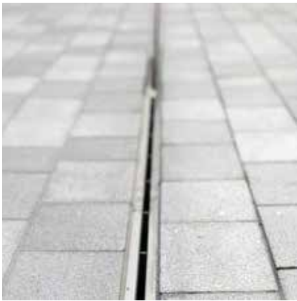
retenční žlaby svádějící vodu do zeleně
