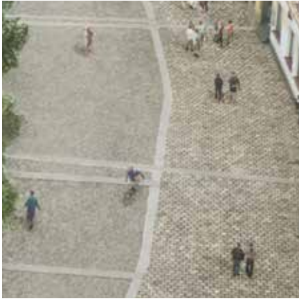
žulové pochozí pásy protínající a propojující náměstí
