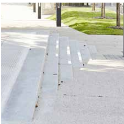
schody ustupující s terénem
