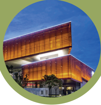
Administrativní centrum a muzeum urbanismu ve Wu-chanu, Arte Charpenter architects 2012
