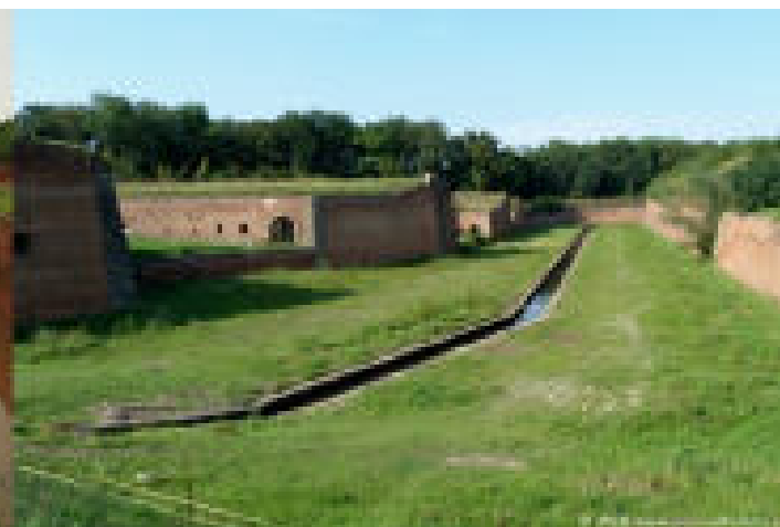
obvyklý stav příkopu
