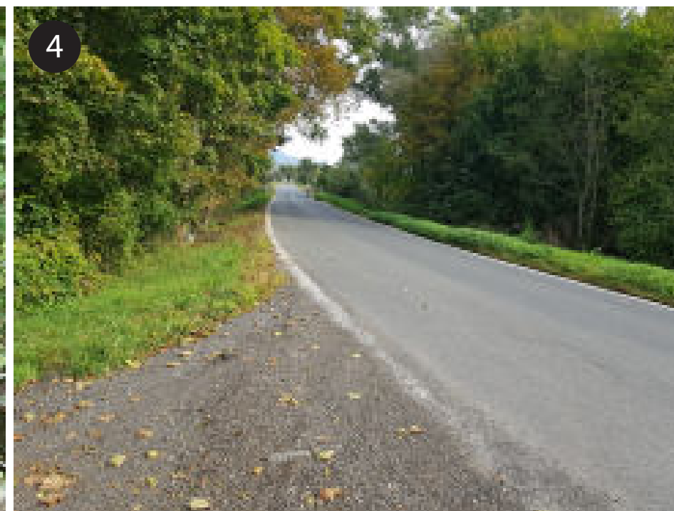
úsek vedoucí po hlavní komunikaci
