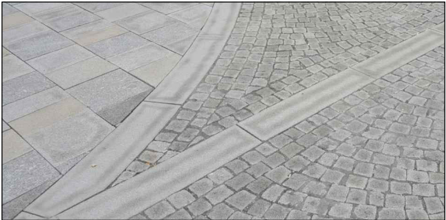
SCHřMA 4 Ilustrace řulovřho obrubnřku (200 x 200 x ař 2000mm)
