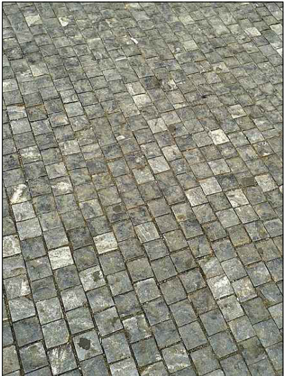
SCHřMA 3 Ilustrace kladu řulovřch kostek 8/10 v řřdcřch
