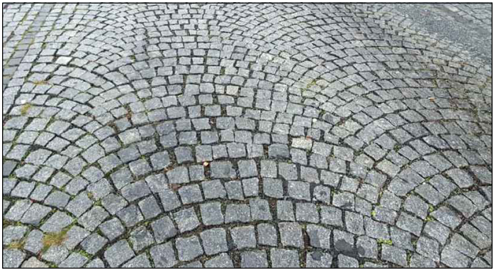
SCHřMA 2 Ilustrace kladu řulovřch kostek 10/12 do vřjřř
