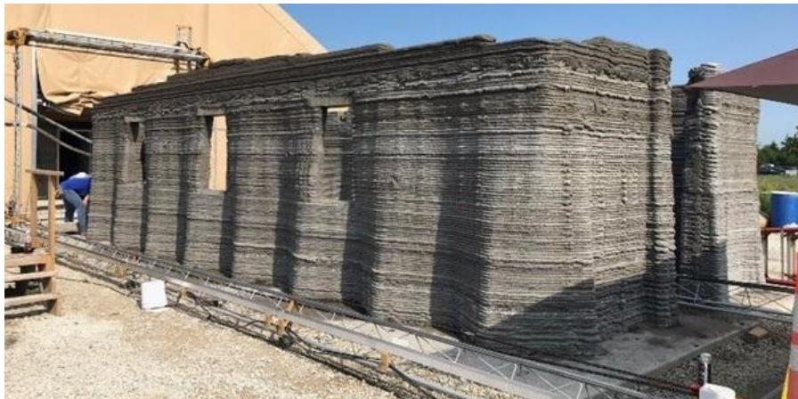
Technologie 3D tisku z polymerního betonu a PET.
