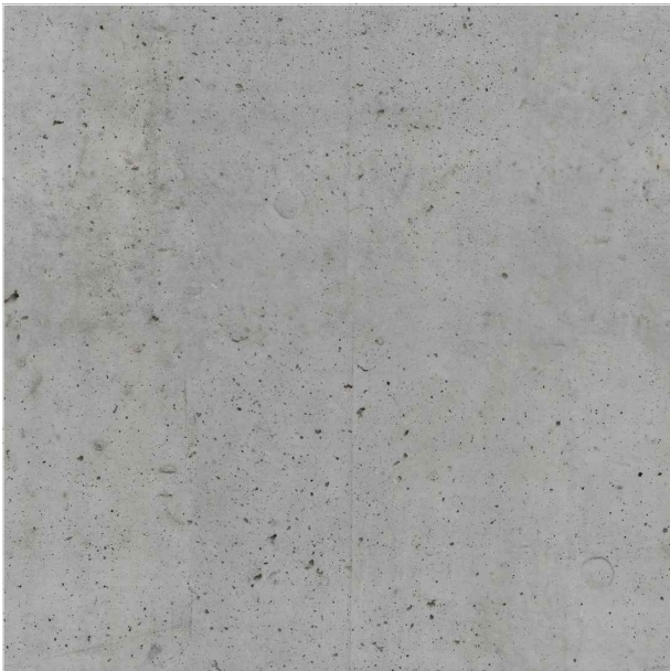
schodiště, podlaha teras
