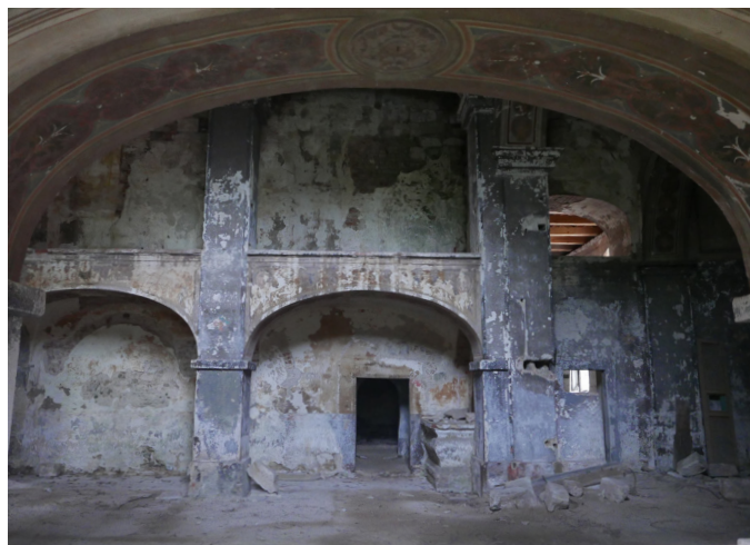
Současný stav empor a presbytáře
