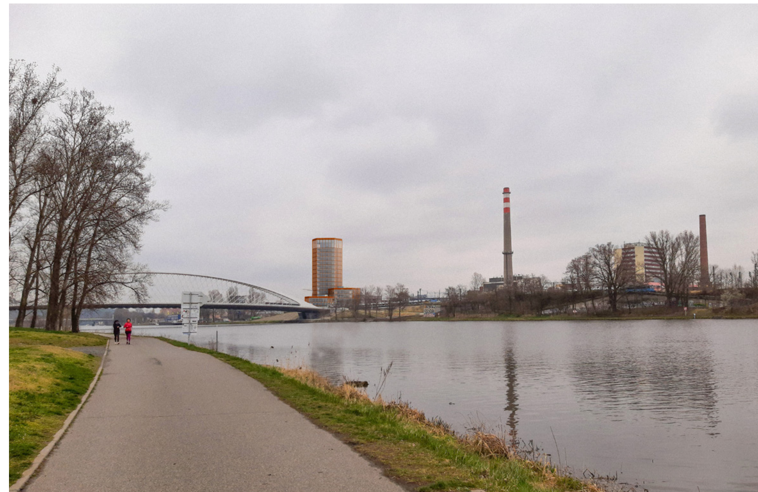
Dálkový pohled od Sportovního Areálu Loděnice
