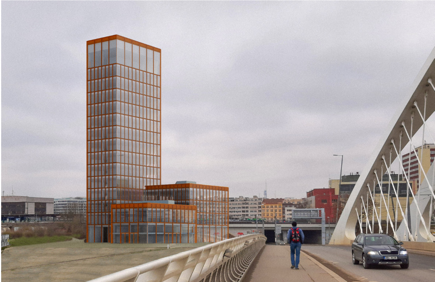
Pohled z Trojského mostu
