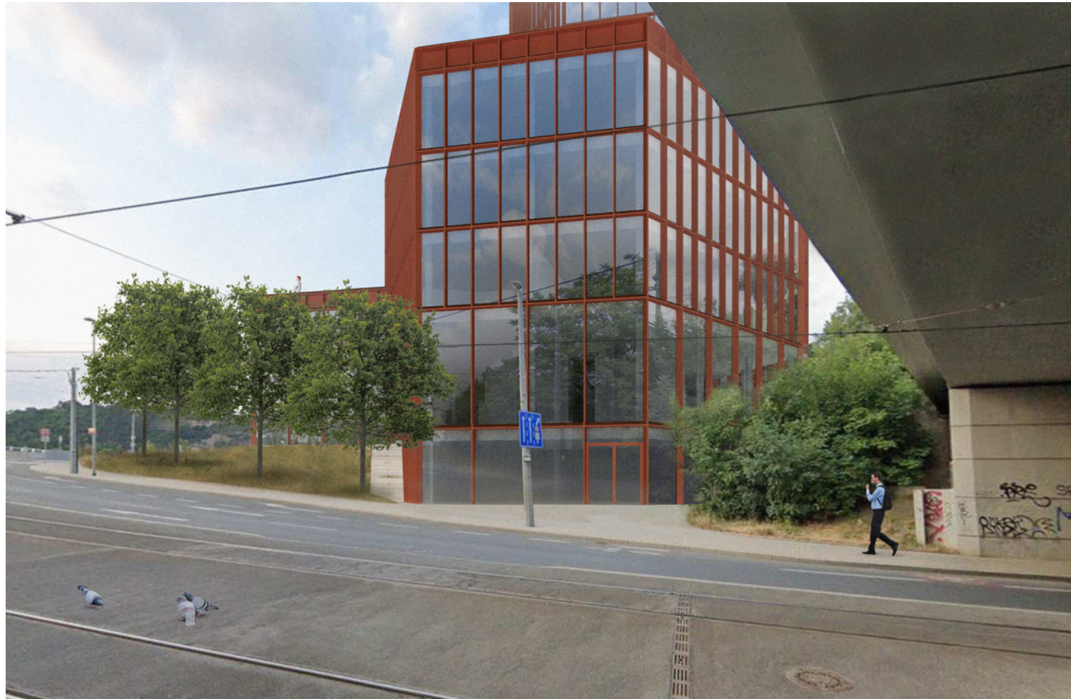
Pohled zespodu železničního mostu
