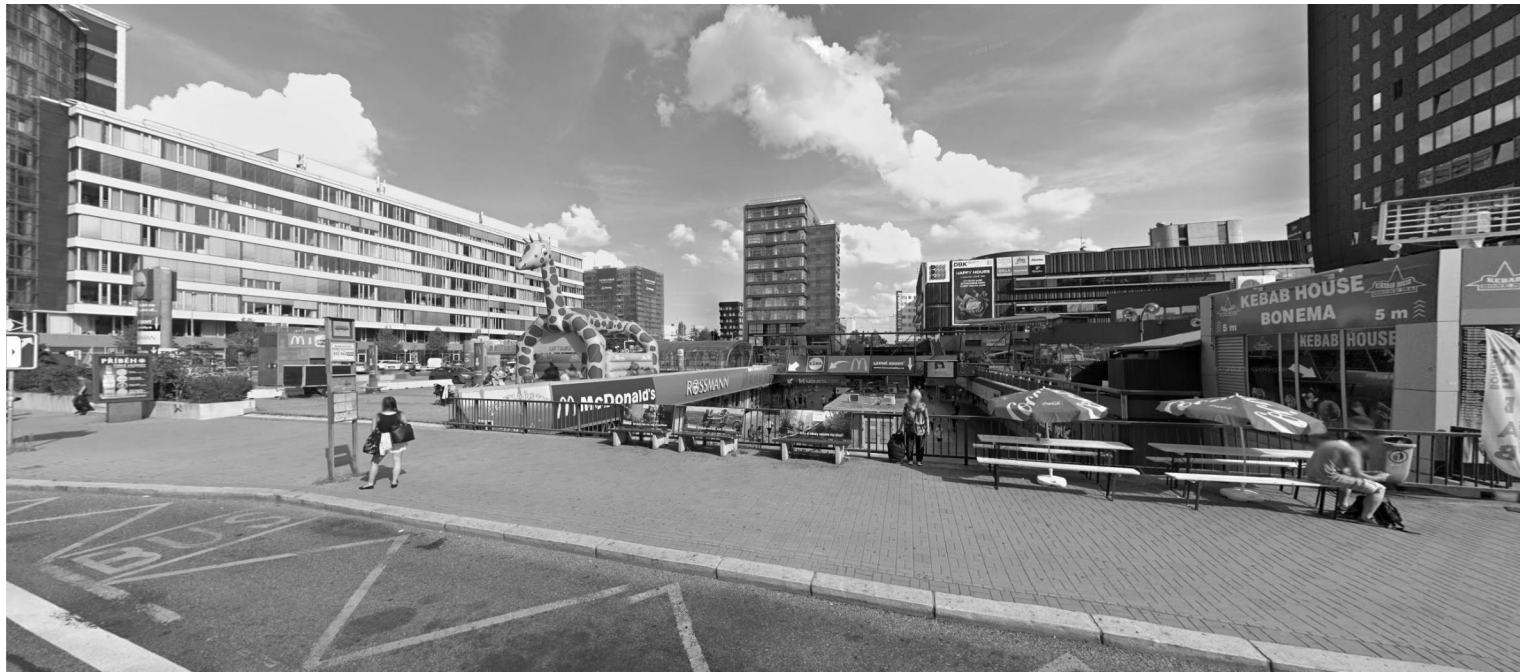
současný veřejný prostor, pohled z Olbrachtovi ulice
