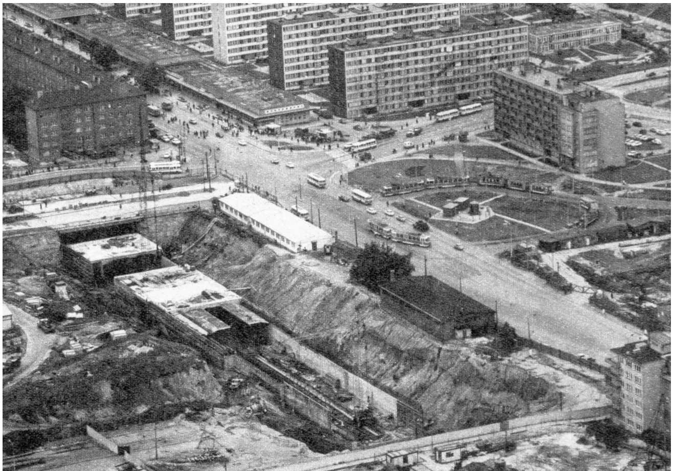
výstavba metra a stanice Budějovické
