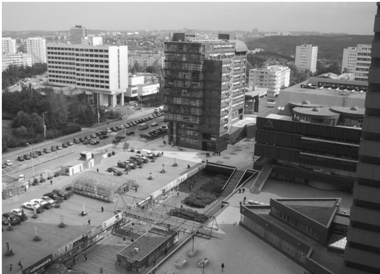
tržiště jako výstup z metra
