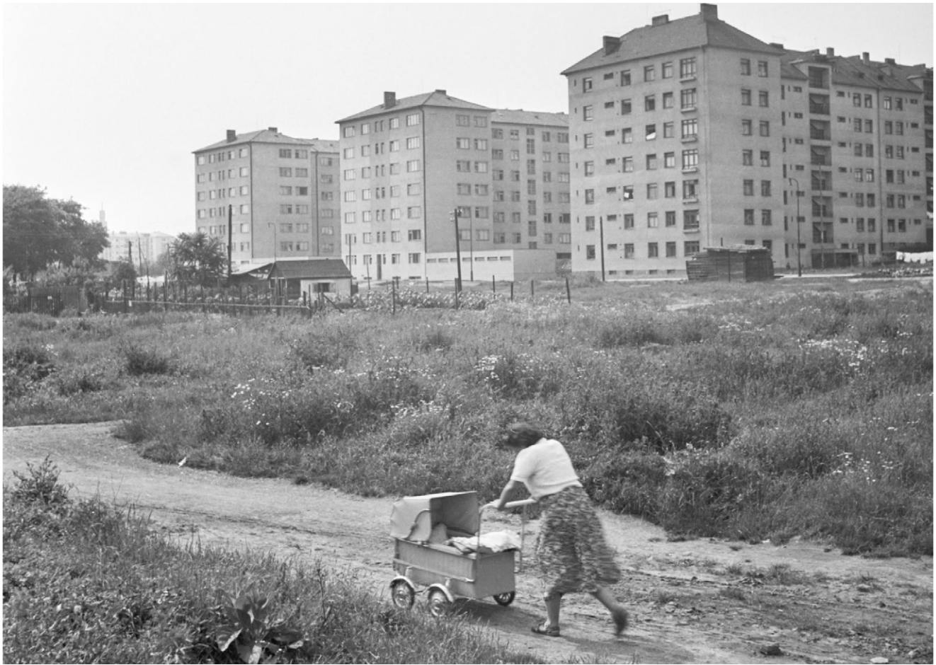
Bytové domy „V Zahrádkách,“ - 1951
