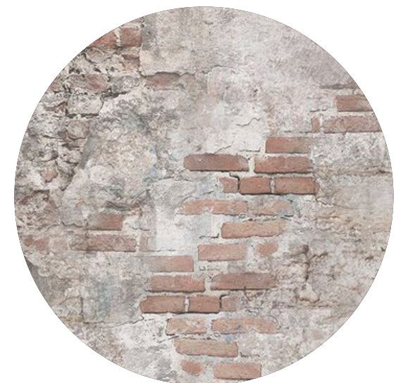
Tehly kladené do malty hrubá povrchová úprava
