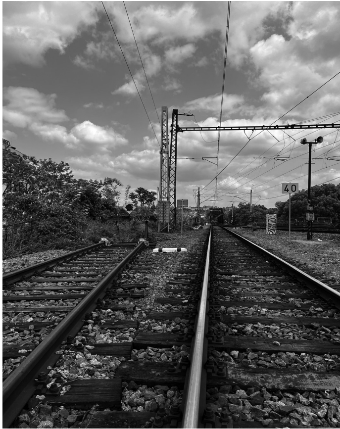
Slepá kolejnice, pohled na železniční most.
