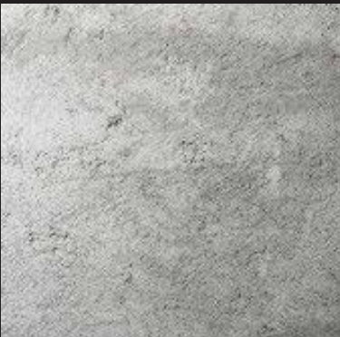
BETON pohledový na stropech
