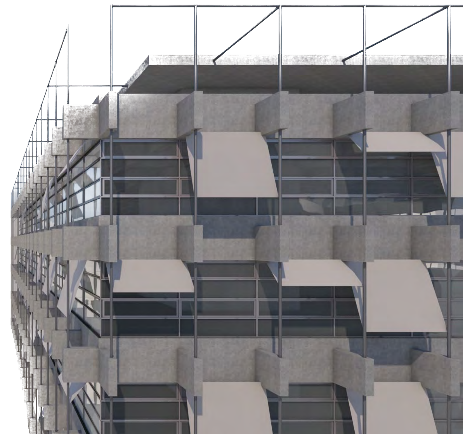
DETAILNÍ POHLED NA FASÁDU
