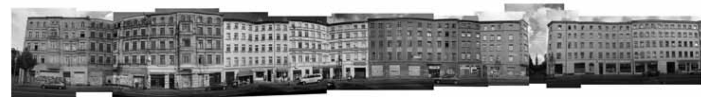
severní strana Eisenbahnstrasse, část sousedící s parcelou, podzim 2011
