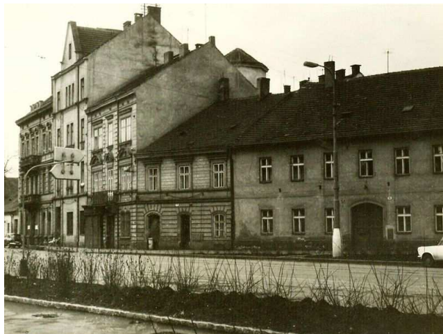
Pohled na dnes neexistující frontu domů na Palackého náměstí.
