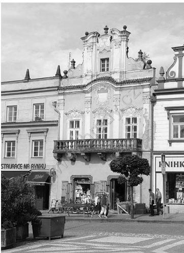
Havlíčkův Brod - Malinův dům, baroko
