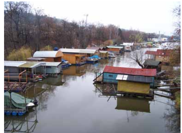
02_Smíchovský přístav byl vybudován v letech 1899–1903 jako ochranný vorový přístav. Podnětem k výstavbě přístavu byla katastrofální povodeň z roku 1890 (zejména poškození Karlova mostu strženými vory). Vytěžením 605 200 m³ zeminy vznikl přístavní bazén, který oddělil území Císařské louky od smíchovského břehu. Dnes slouží jako ochranný přístav právě v případě povodní, jinak je využíván pro skladové účely a parkoviště hausbótů.
