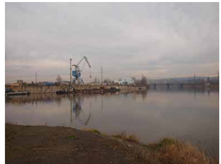
01_Radotínský přístav leží na břehu Berounky asi 600 m nad soutokem s Vltavou. Byl budován od roku 1983. Je určen pro překládku šterkopísku a dalších stavebních hmot a velmi těžkých a rozměrných výrobků. Slouží také jako pronajímatelná skladová plocha.
