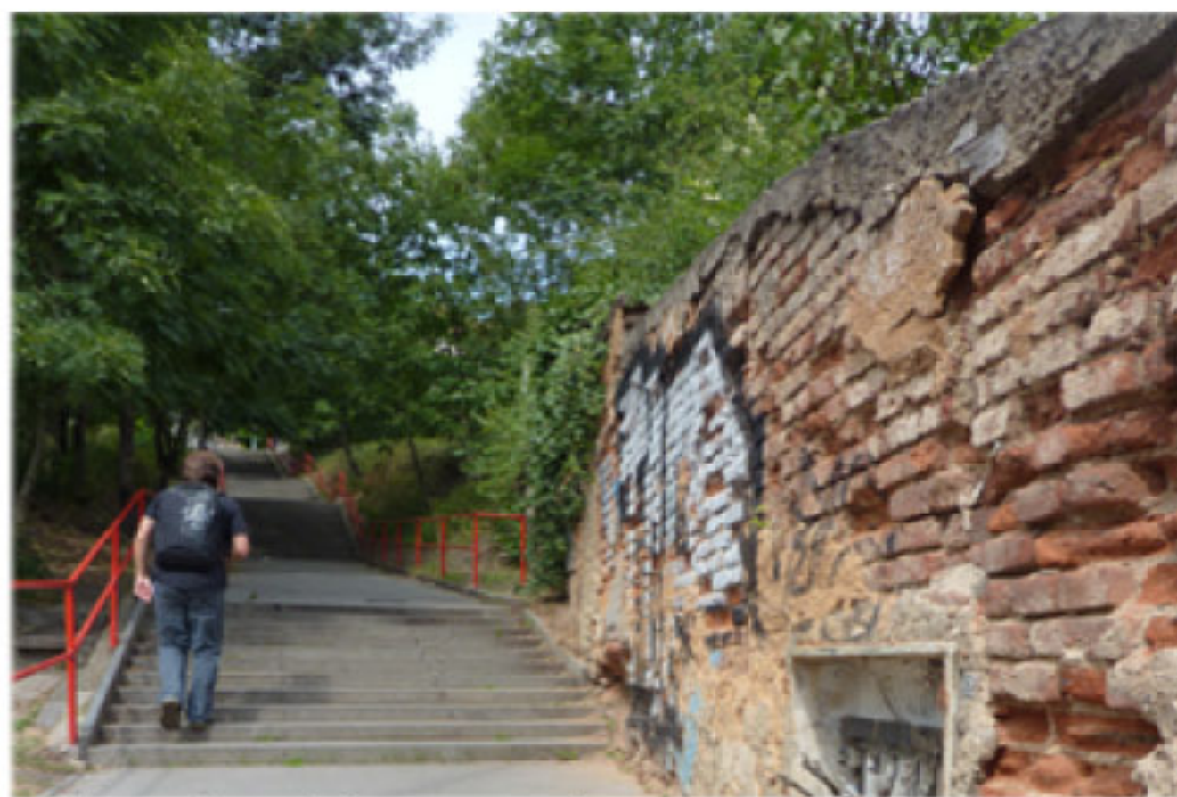
ZEĎ ODDĚLUJÍCÍ PODOLSKÉ SCHODY OD POZEMKU
