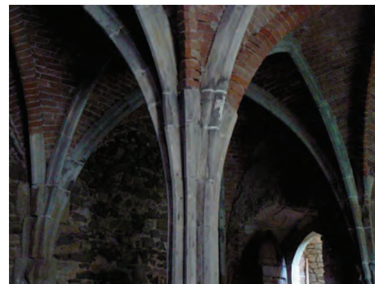
Nové vyklenutí klenby s použitím gotických žebel, klášter Rosa Coeli, Dolní Kounice, kolem 1700
