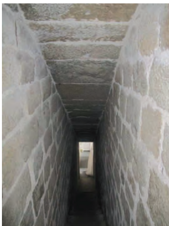
Zastropení schodiště v tloušťce zdi kamennými deskami, sv. Jiljí, Milevsko
