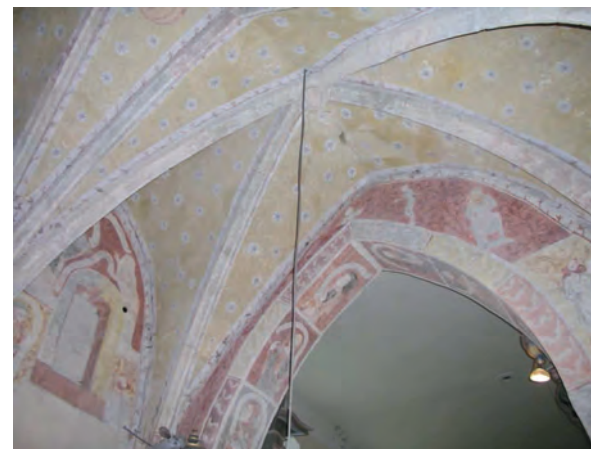
Zazděné okénko z oratoře do lodi, kostel sv. Vavřince, Kozlany
