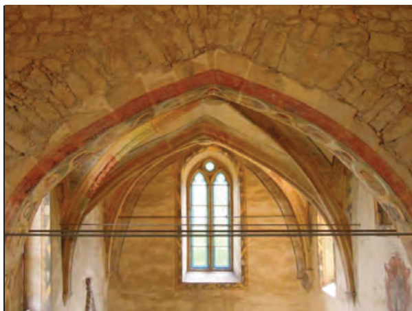
Pohled z lodi do presbytéria – nerovnosti v průběhu žebel
