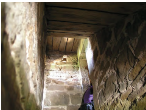
Dřevěné zastropení schodiště v tloušťce zdi, Pařížov
