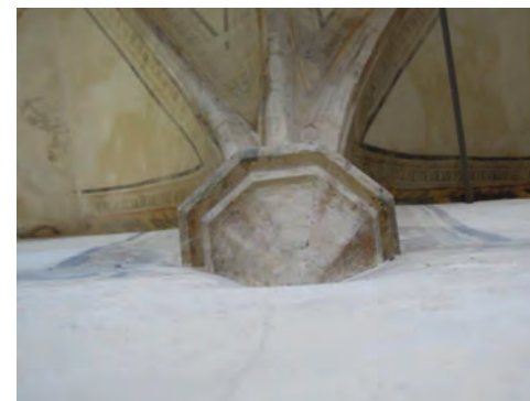
Jižní stěna presbytéria – konzola utápějící se v rozvlněném líci zdi
