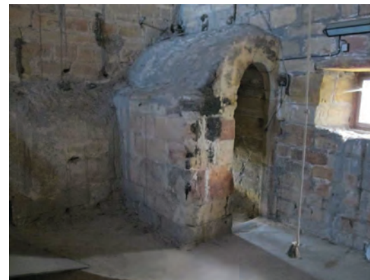
Uzavíratelné vyústění schodiště v tloušťce zdi lodi do věžního patra nad tribunou v kostele sv. Bartoloměje v Praze-Kyjích
