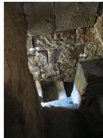
Neuzavíratelná variantavyústění schodiště v tloušťce jižní zdi kostela v premonstrátském klášteře v Teplé
