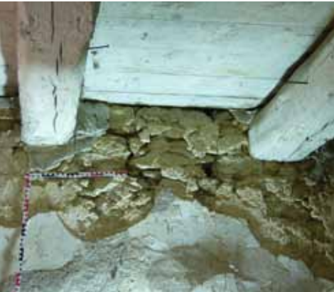
DETAIL TRÁM. STROPU SE ZÁKLOPEM
