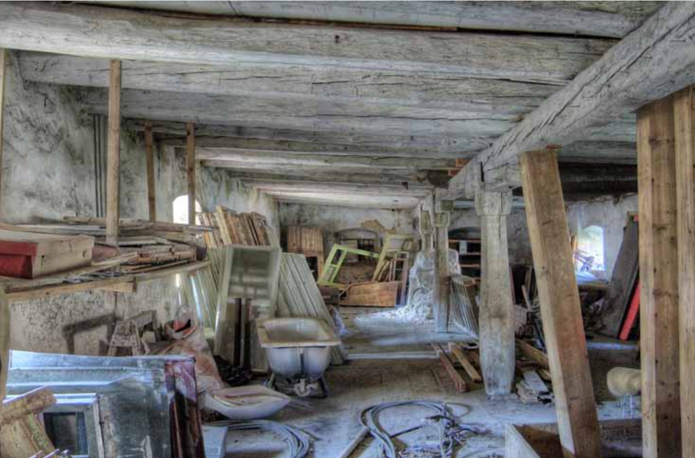
POHLED PŘÍZEMÍM SÝPKY K SEVERNÍ STĚNĚ, VPRAVO POZŮSTATKY KAPSOVÉHO VÝTAHU
