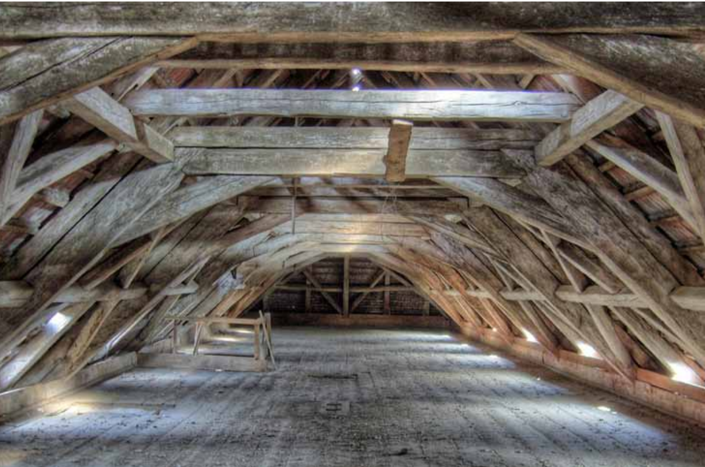
POHLED KROVEM K VÝCHODNÍ VALBĚ, VLEVO ÚSTÍ SCHODIŠTĚ Z PATRA
