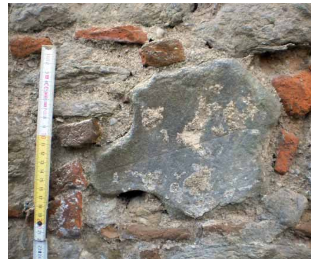
NÁLEZOVÁ SITUACE Č. SB - DRUHOTNĚ POUŽITÉ GOTICKÉ KLENEBNÍ ŽEBRO V OPRAVĚ SEVERNÍ OBVODOVÉ ZDI RATEJNY. VYSPRÁVKA POCHÁZÍ Z ROZMEZÍ LET 1848 - 1850. V TOMTO ÚSEKŮ JE RŮZNĚ OPRACOVANÝCH KAMENŮ ZE STEJNÉHO MATERIÁLU (ŠEDÝ PÍSKOVEC) POUŽITO VÍCE. MATERIÁL MŮŽE POCHÁZET Z ROZVALIN NEDALEKÉHO GOTICKÉHO KOSTELÍKU SV. KATEŘINY NA ČEJKÁCH.
