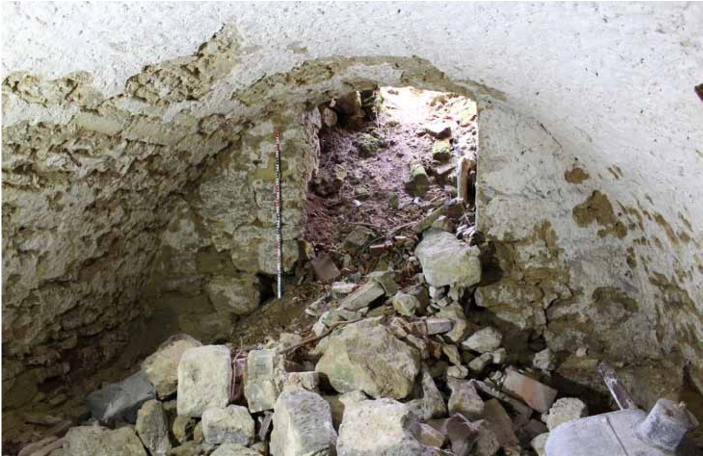
POHLED KE SEVERNÍ ČELNÍ STĚNĚ SE ZBYTKY PŘÍSTUPOVÉ ŠÍJE Z PŘEDSKLEPA
