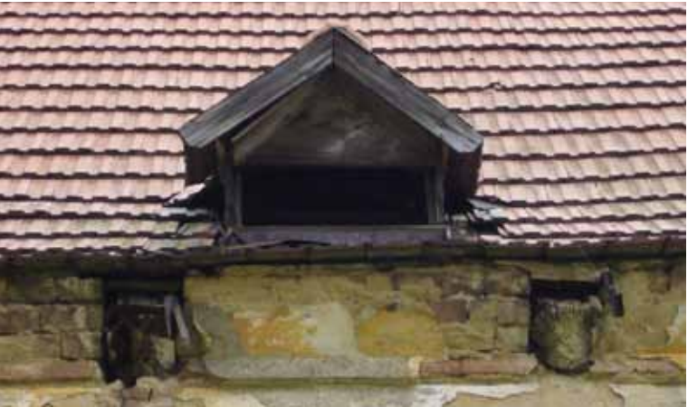
EXTERIÉR VIKÝŘE S DETAILEM UKONČENÍ VAZNÝCH TRÁMŮ
