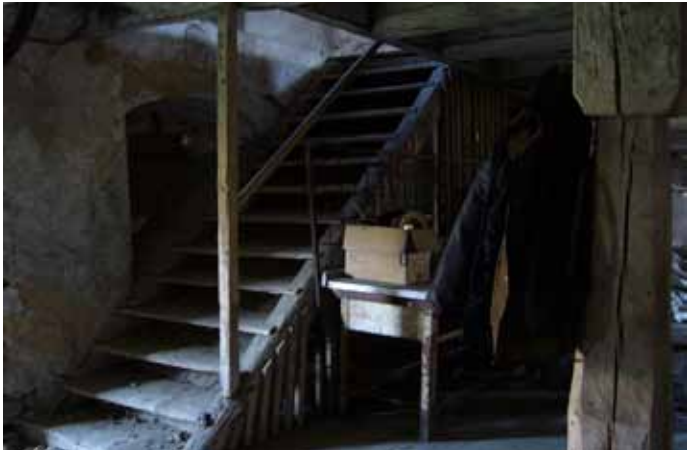
SCHODY DO PATRA PŘI SEVERNÍ STĚNĚ
