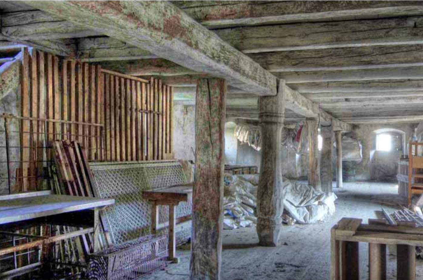
POHLED PŘÍZEMÍM SÝPKY K VÝCHODNÍ STĚNĚ, VLEVO KÓJE POD SCHODY
