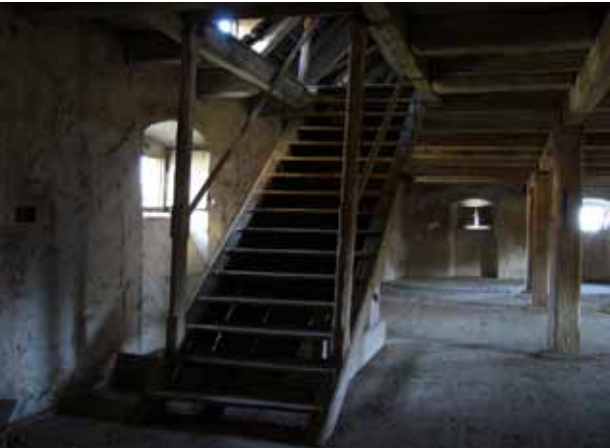
SCHODIŠTĚ DO KROVU
