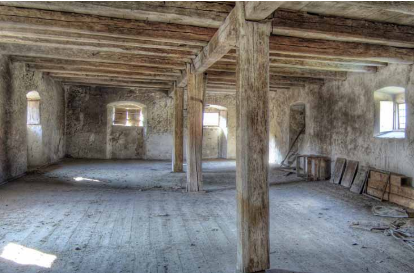
POHLED SÝPKOVÝM PATREM K SEVERNÍ STĚNĚ
