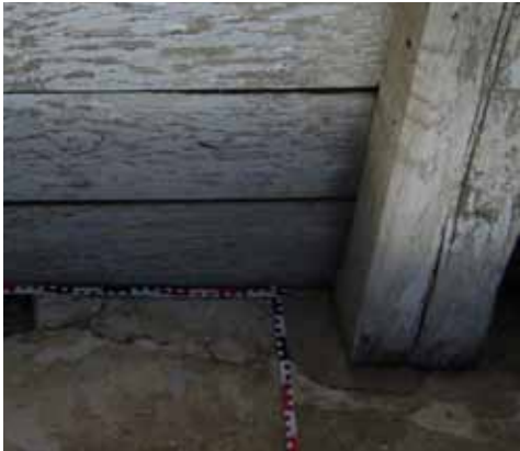
DETAIL STROP. TRÁMU SE ZÁKLOPEM
