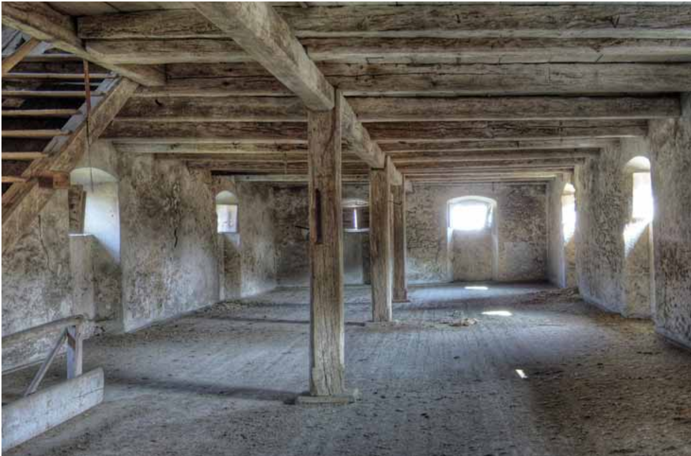
POHLED SÝPKOVÝM PATREM K VÝCHODNÍ STĚNĚ, VLEVO SCHODIŠTĚ Z PŘÍZEMÍ A DO KROVU
