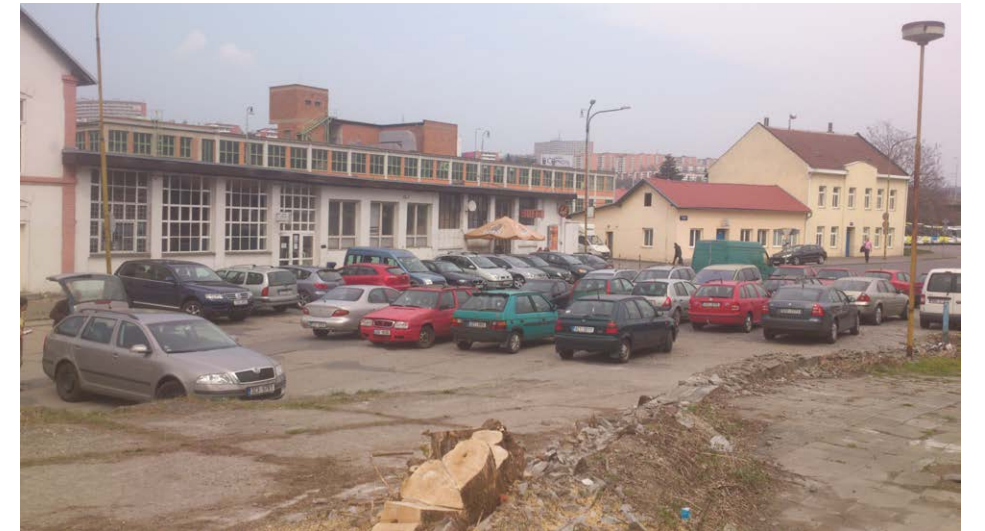
Předprostor budovy vlakového nádraží
