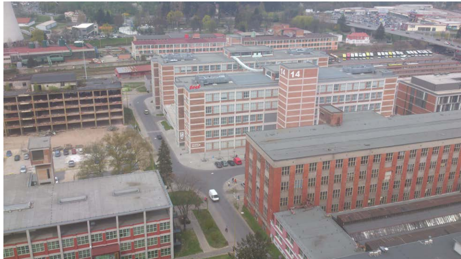
Pohled z budovy 21.
