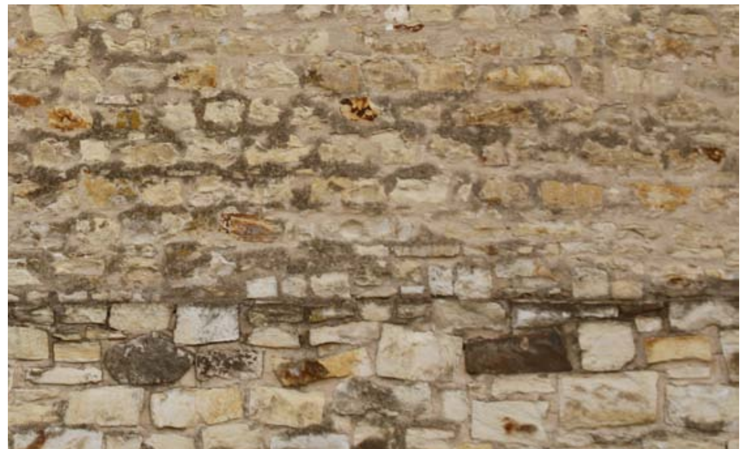
detail opukového hradebního zdiva
