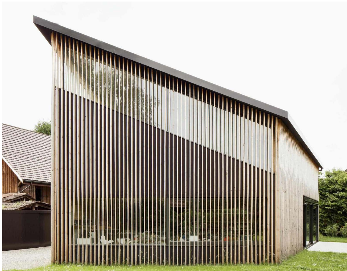
GRAMAZIO & KOHLER, súkromný dom, Švajčiarsko -inšpirácia zakrytých okien
