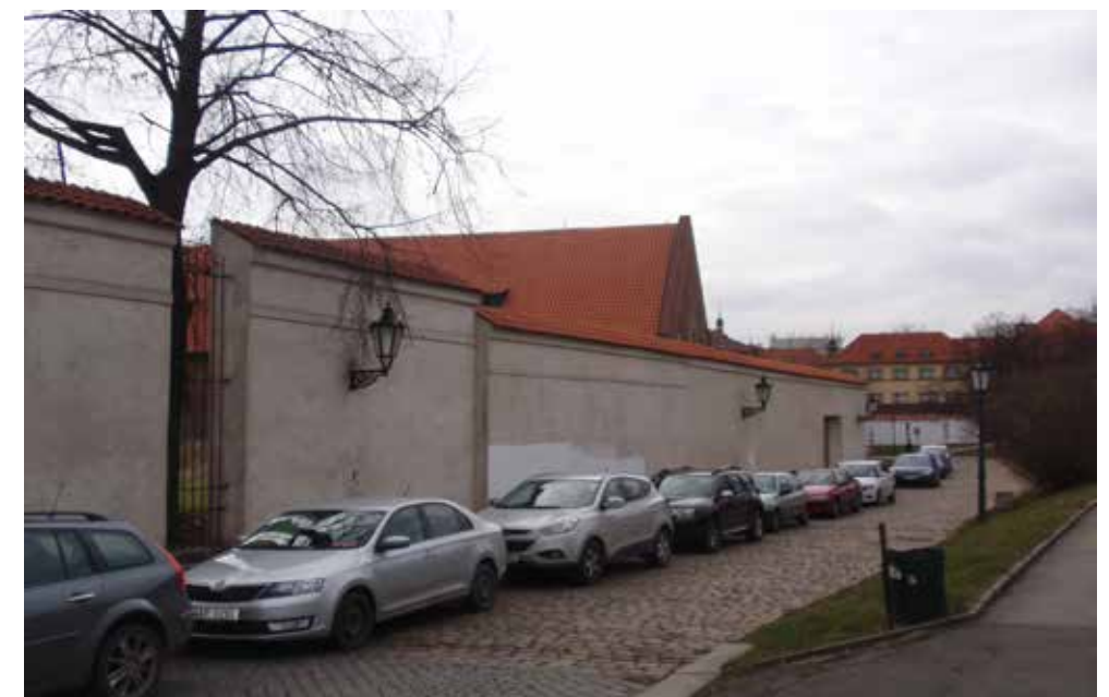
parkoviště před vstupem do areálu kláštera
