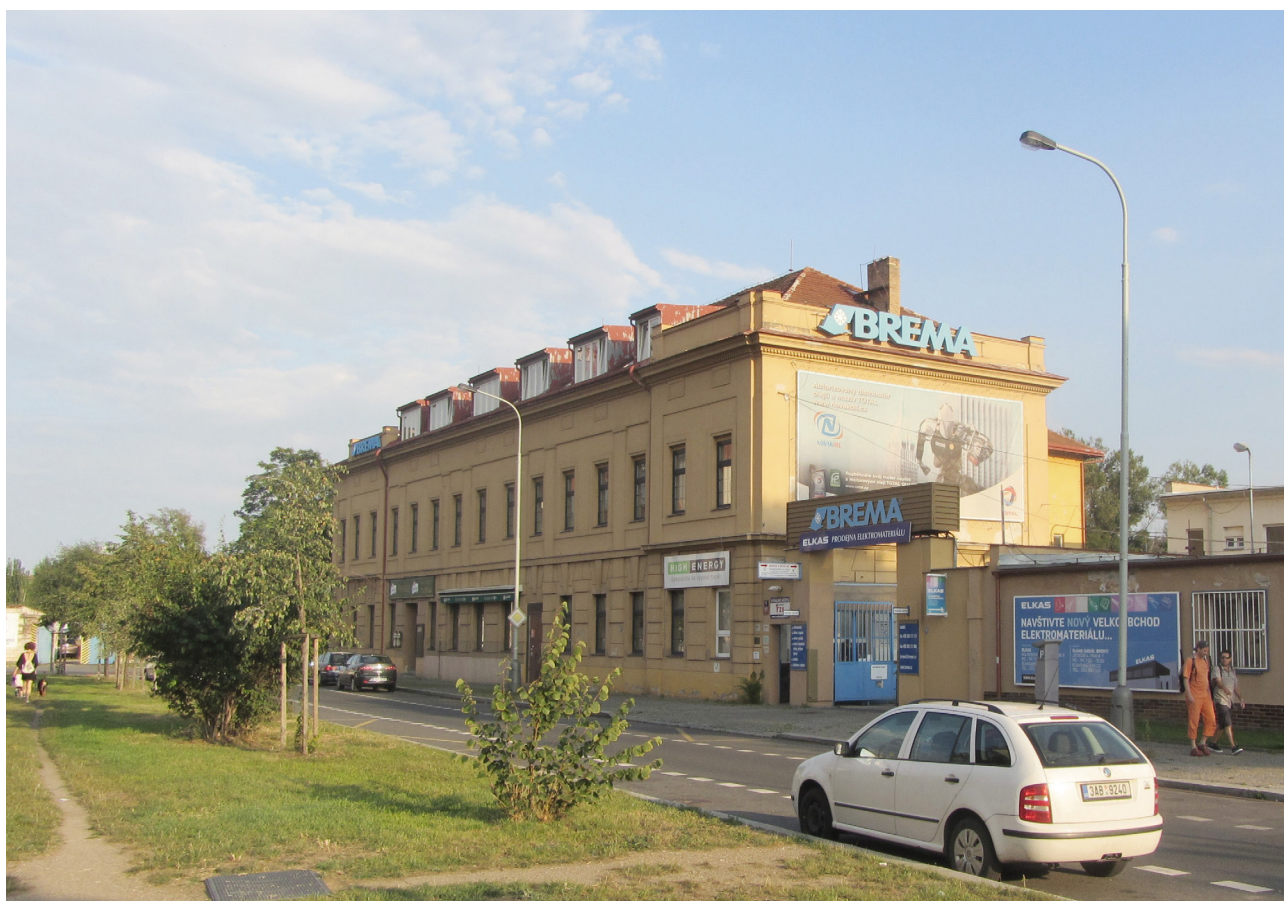
Jateční ulice - historická budova naproti řešenému bloku
