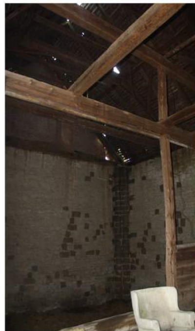
Pohled do prostoru krovu
