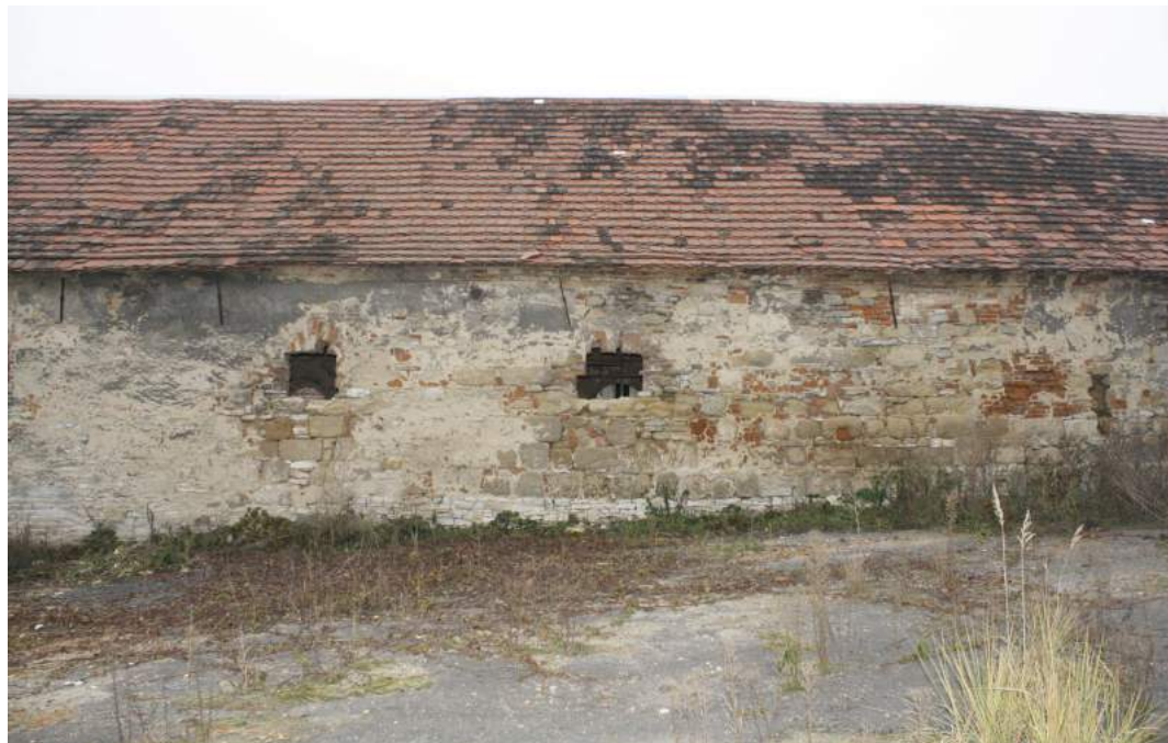
Východní fasáda objektu
