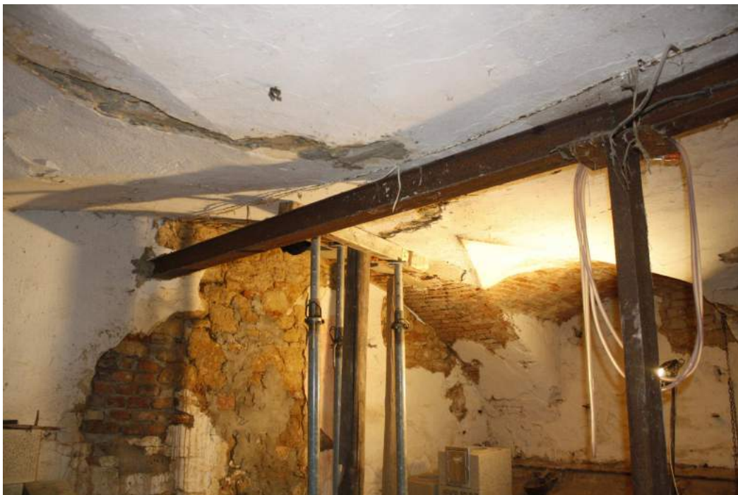
Podpření porušené klenby v přízemí
