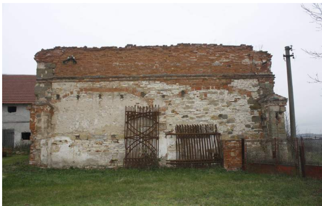
Pohled na západní (štítovou) zeď
