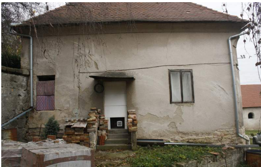
Západní fasáda objektu
