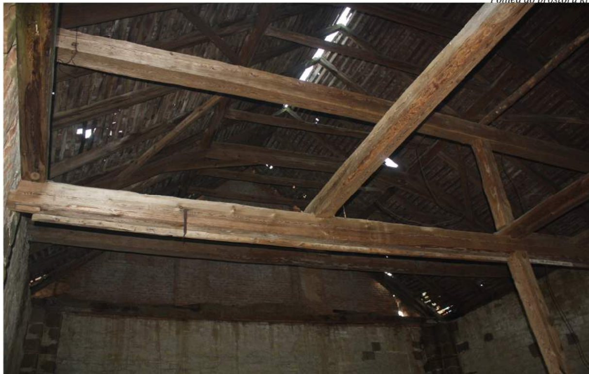
Pohled do prostoru krovu
