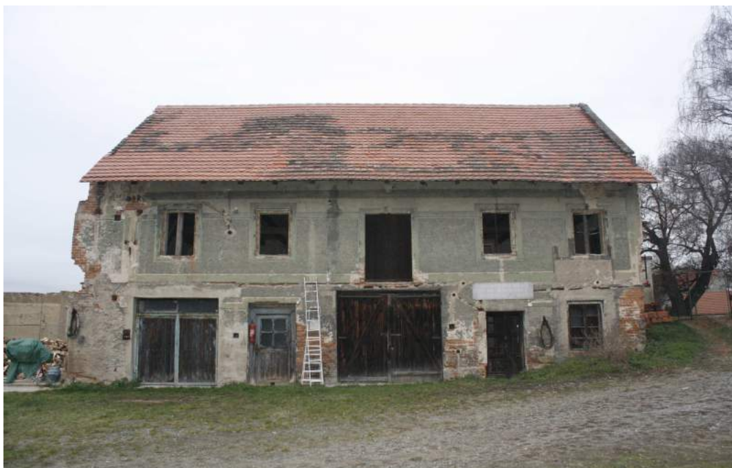
Východní fasáda objektu
