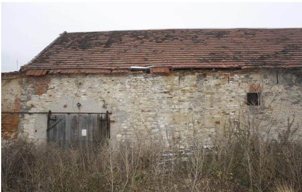
Východní fasáda objektu
