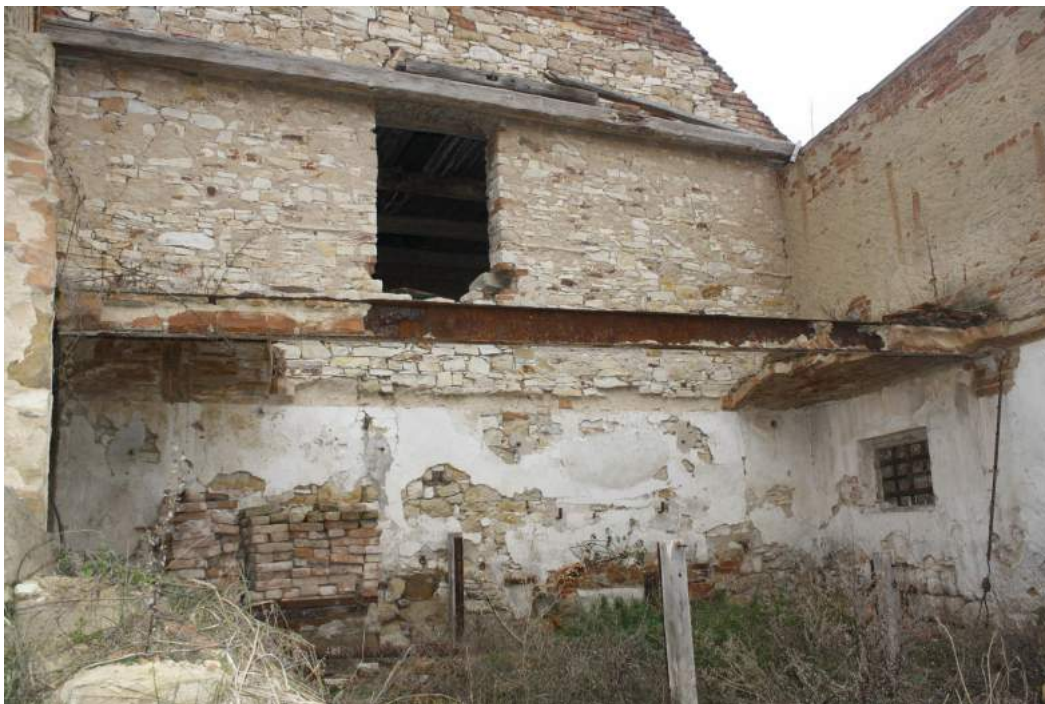
Severní dvoupatrové „křídlo“ s částečně dochovanou segmentovou klenbou
