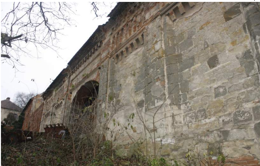
Pohled na západní fasádu
