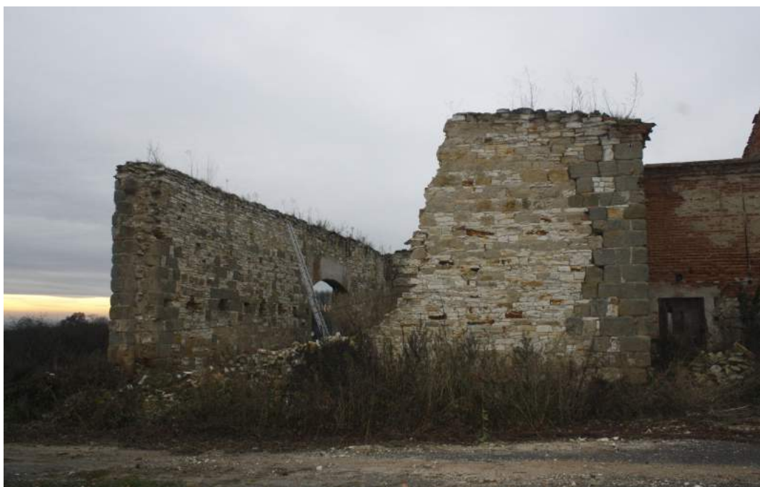
Pohled na východní (štítovou) zeď
