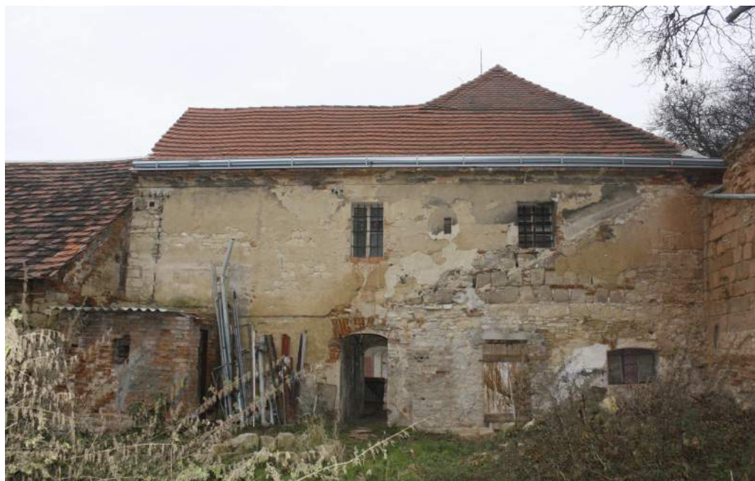
Východní fasáda objektu
