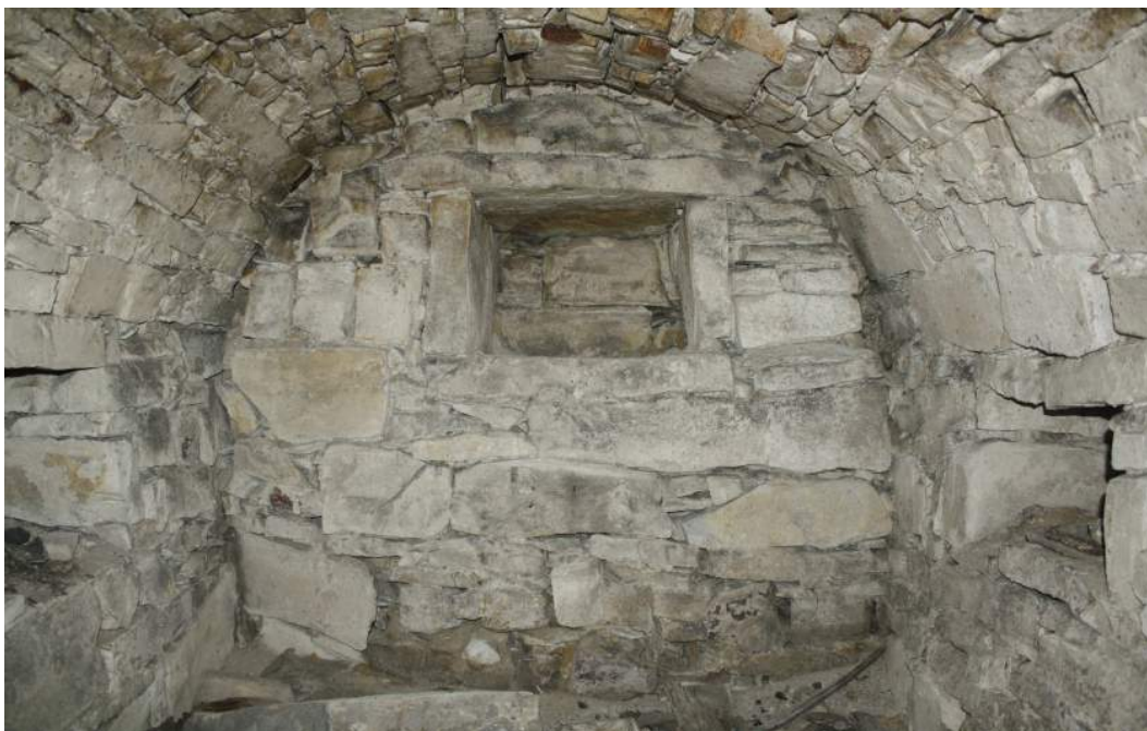
Kamenný sklípek/lednice zasahující pod pozemek fary
