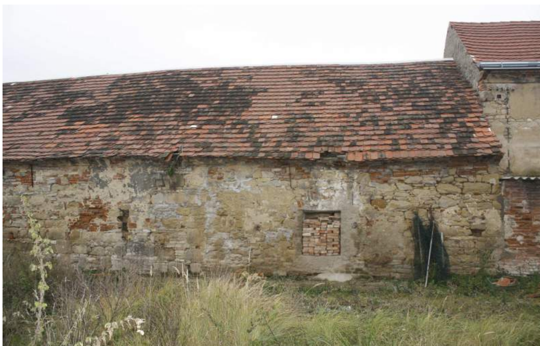
Východní fasáda objektu
