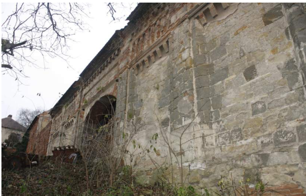
Západní fasáda objektu
