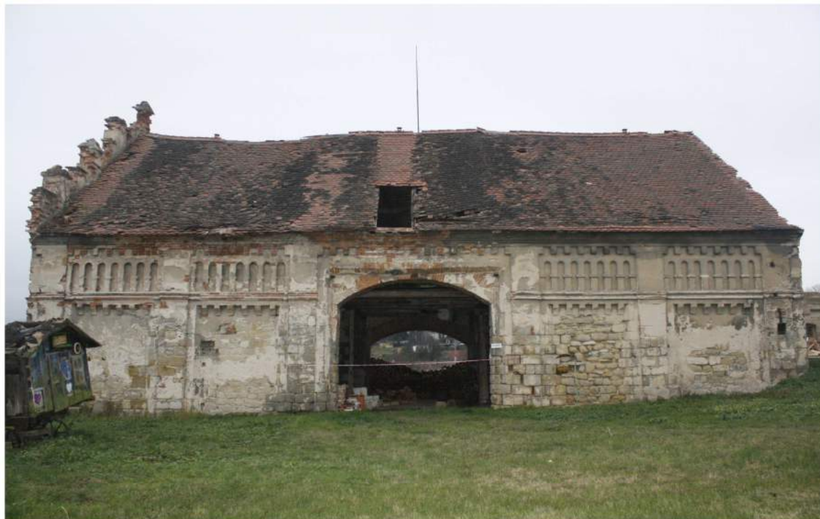
Pohled na východní fasádu
