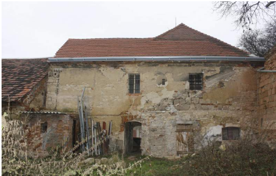
Východní fasáda objektu „A“ - otisk pultové střechy
