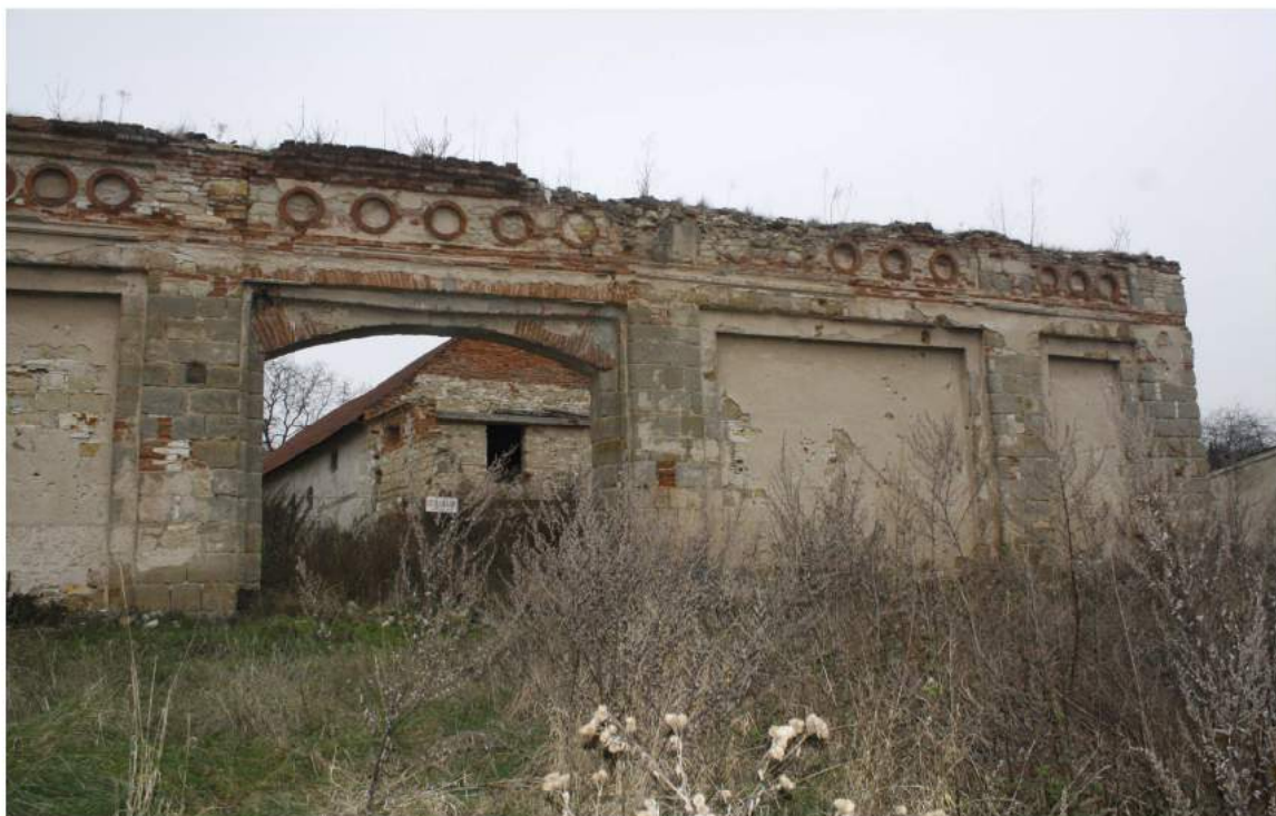
Pohled na fasádu
