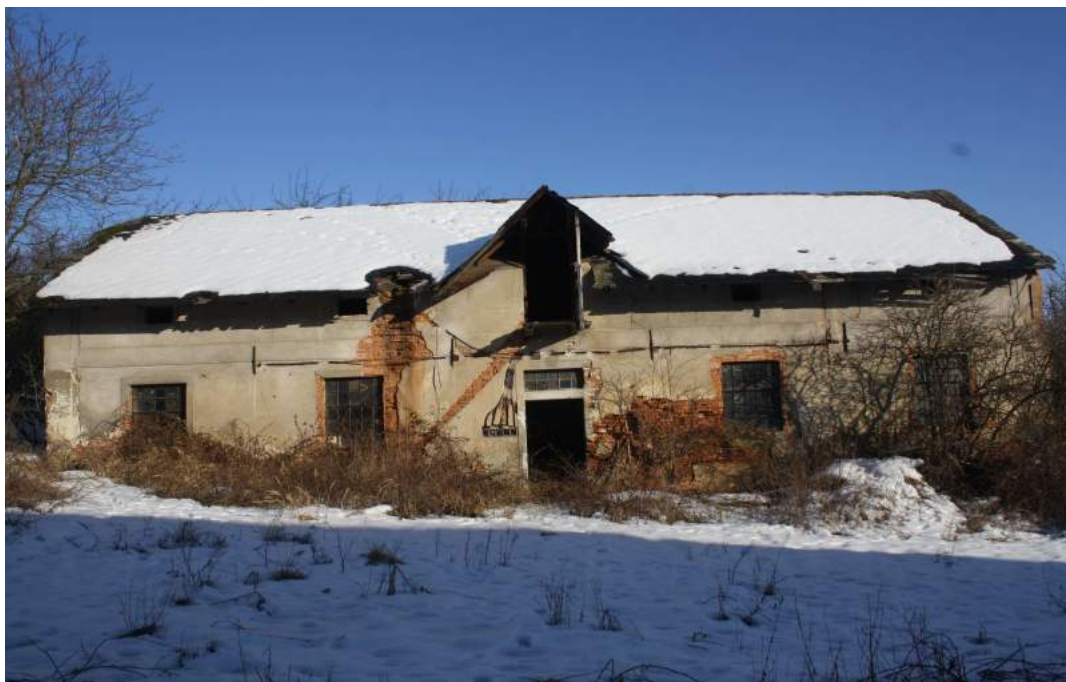
Západní fasáda objektu
