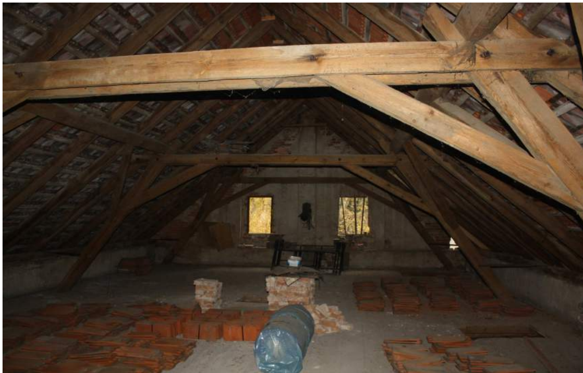
Pohled do prostoru krovu
