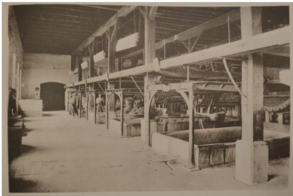
Varna hadrů, zde se hadry povařily a následně vpustily do pracích a následně mlecích holandrů; před r. 1912 (sborník ke stému výročí narození G. R., soukromý archiv)
