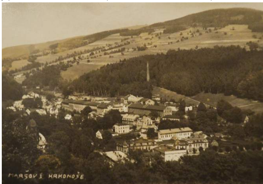
Pohled od Muchmůrky, oblouková střecha je dostavěna, pod komínem je rozestavěná nástavba na objektu varny hadrů; duben 1947 (soukromá sbírka)
