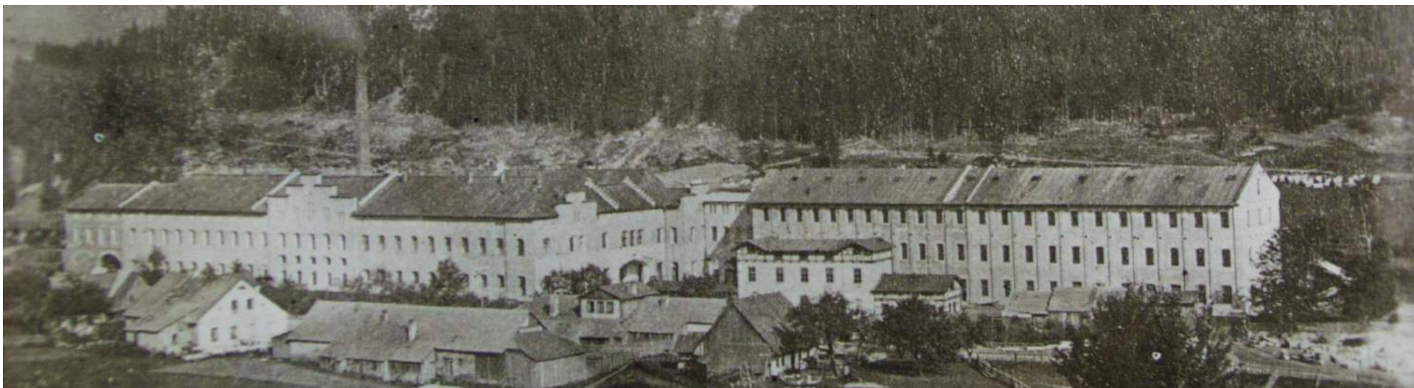
Papírna již se severní přístavbou, kde je jeden z klenutých pasů otevřen a jižní přístavbou hadrárny z roku 1872. Na fotografii jsou již stojící budovy kancelářů; 1872 - 1874 (archiv NTM)
