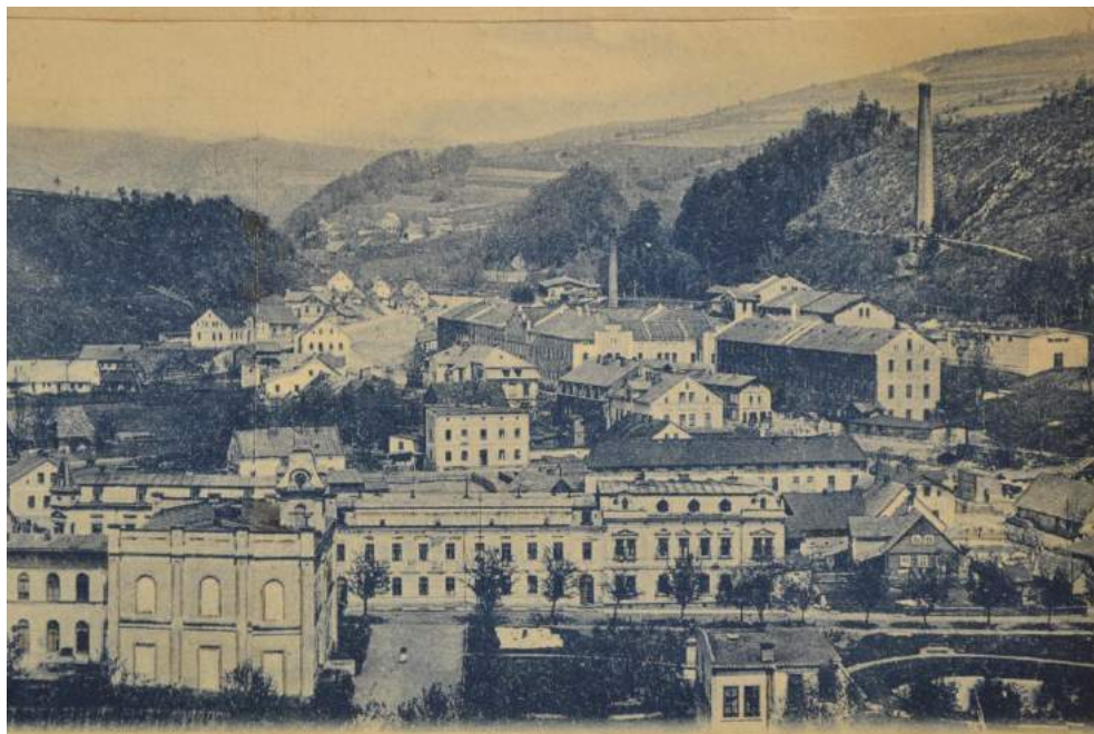
Pohled od Muchmůrky, v pravé části je menší objekt, který mohl plnit funkci vrátnice, objekt nové vrátnice je právě rozestavěn; kolem roku 1900 (archiv Muzea Podkrkonoší v Trutnově)
