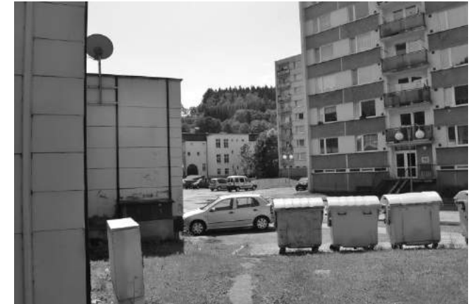
Rýchorské sídliště s průhledem na zadní části domů u Pietteho náměstí
