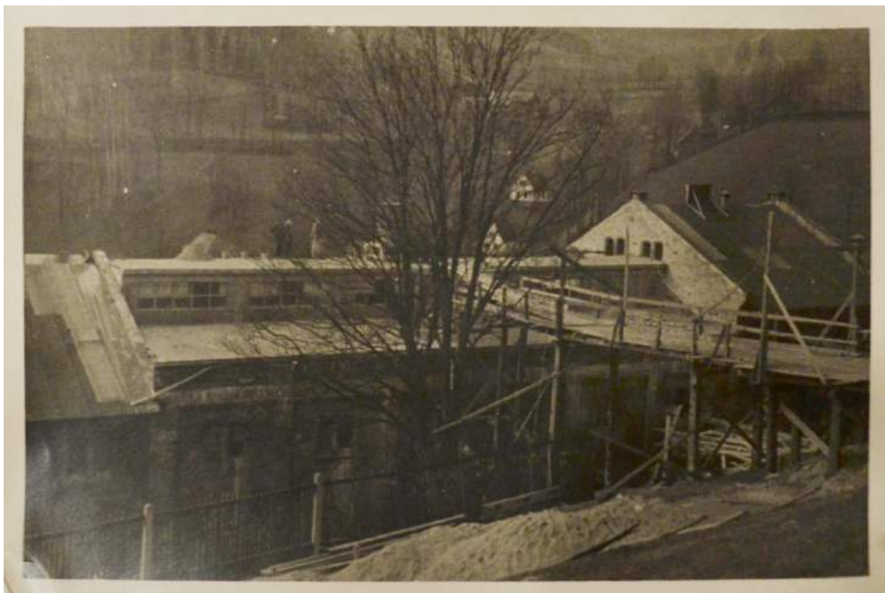
výstavba nového zastřešení s bazilikálním osvětlením; r. 1947 (soukromý archiv)
