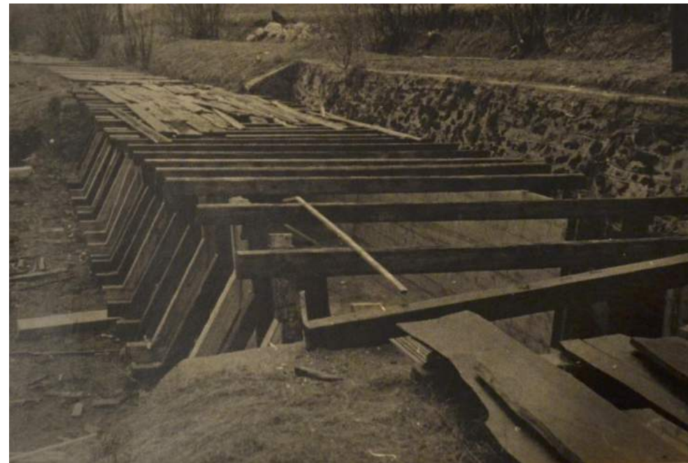
oprava vodního náhonu; r. 1947 (soukromý archiv)
