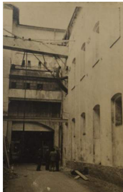
průchod mezi objekty E1 a F1; r. 1947 (soukromý archiv)
