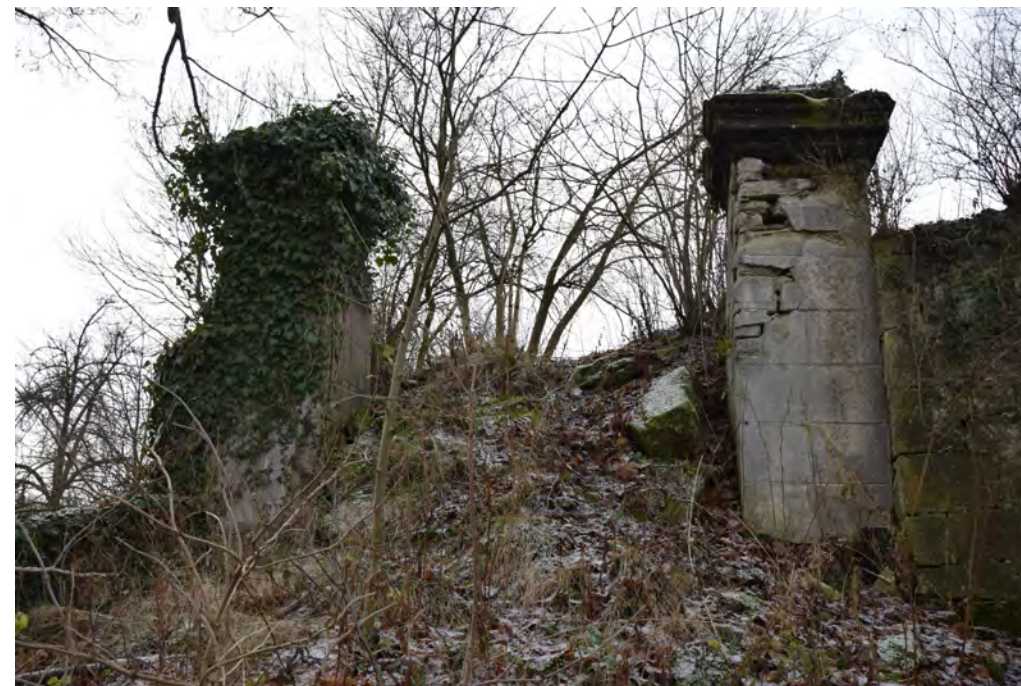
Vyústění trachytového schodiště u vstupu k bývalému kostelu
