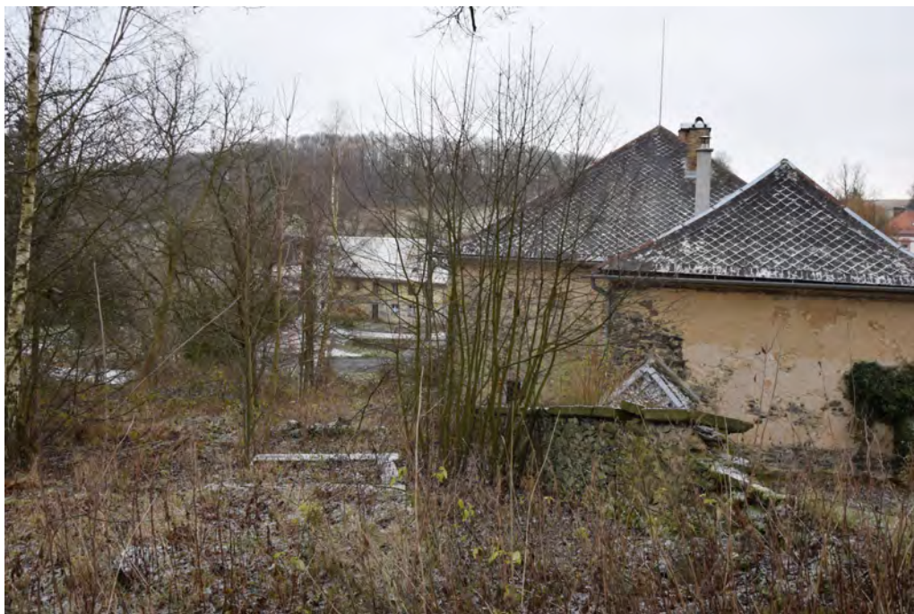
Pohled z trachytového schodiště směrem ke kapličce
