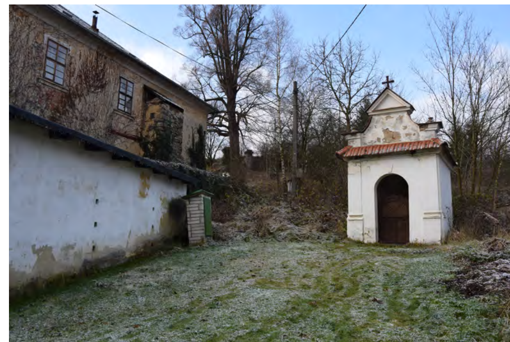
FOTODOKUMENTACE FARY – SOUČASNÝ STAV
