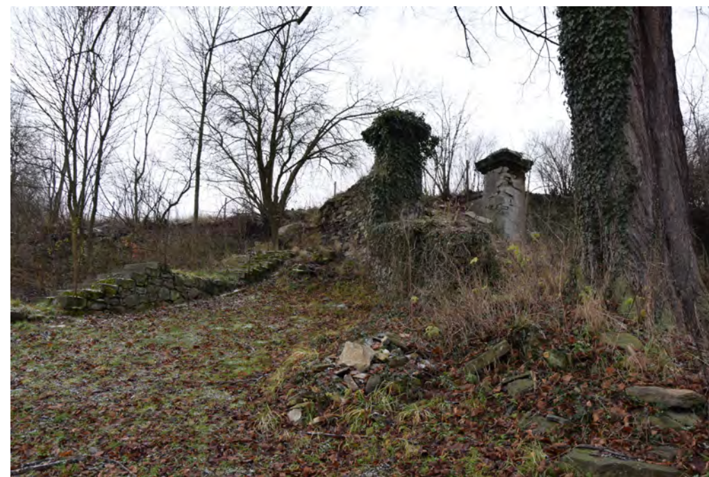
FOTODOKUMENTACE FARY – SOUČASNÝ STAV
