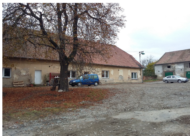
pohled na blok C, dnešní kancelář
