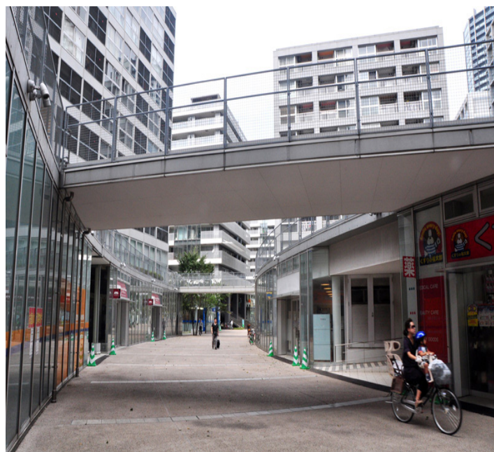
Obr. č. 17 Codan Shinonome / vnitroblok, obchodní parter
