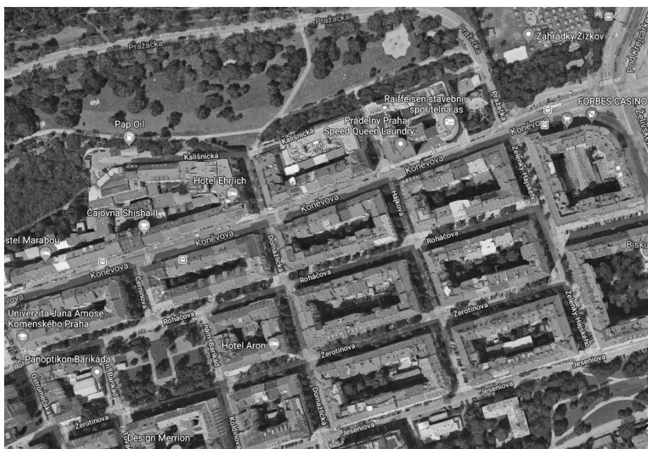
Obr. 1 příklad blokové zástavby, Praha, Žižkov
