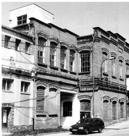
POHLED NA BUDOVU BÝVALÉ KOTELNY
