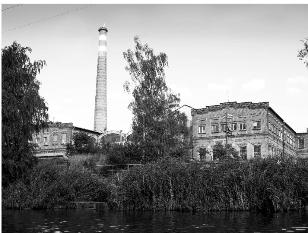
POHLED OD ŘEKY NA BÝVALOU HALU BĚLIDLA
