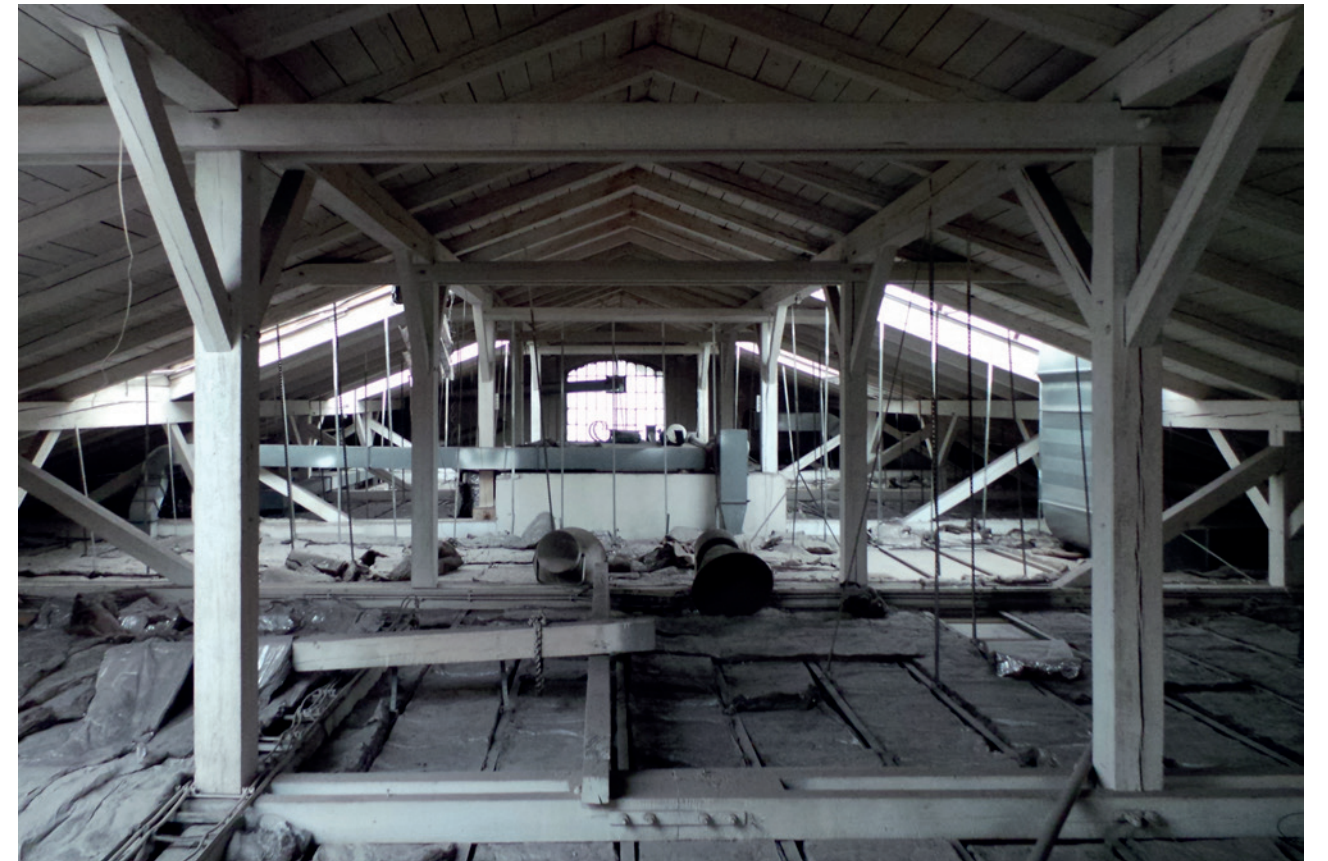
pohled do krovu nad podhledem
