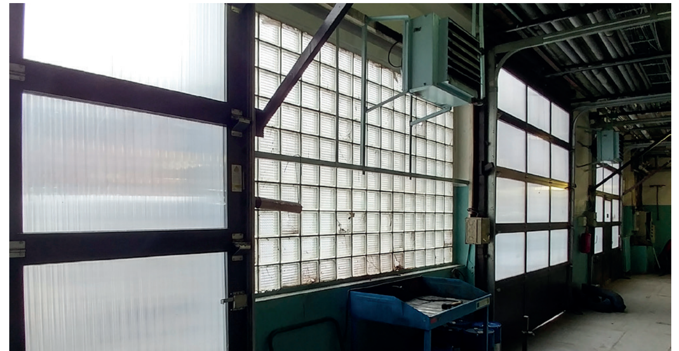
Severní průčelí vozovny, pohled z interiéru
