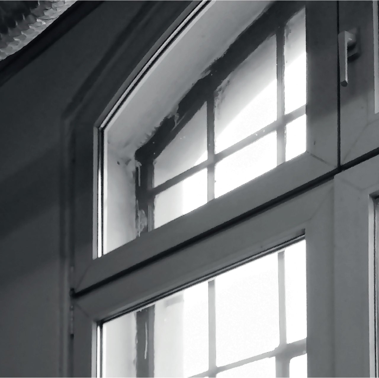
Současné řešení druhých oken na vnitřní straně ostění
