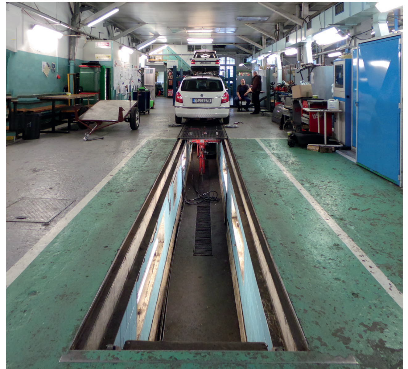
Povrch stávající stěrkové podlahy a montážní jáma
