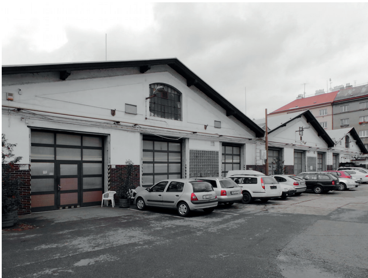
Současný stav severní fasády
