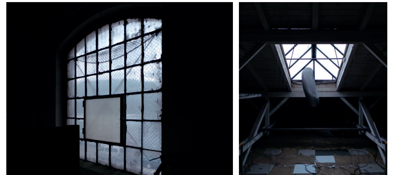
Původní výplně – okno a světlík
