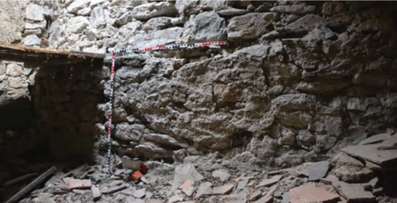
Relikt bergfritu milešovského hradu pod střechou spojovacího krčku mezi barokním palácem a čtyřkřídłym zámkem, originálně dochovaný středověký líc zdiva, foto Ivan Peřina 2013
