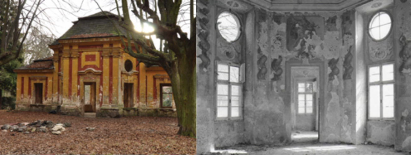
Pohled na casino z úpatí kopce Šibeník, foto: Táňa Šímková 2011 Interiér střední části casina s relikty nástěnných maleb, stav v roce 1995, NPÚ v Ústí n. L., fotoarchiv, inv. č. 110417
