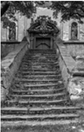
Schodiště vedoucí ke kostelu, foto: Martin Frouz 2014
