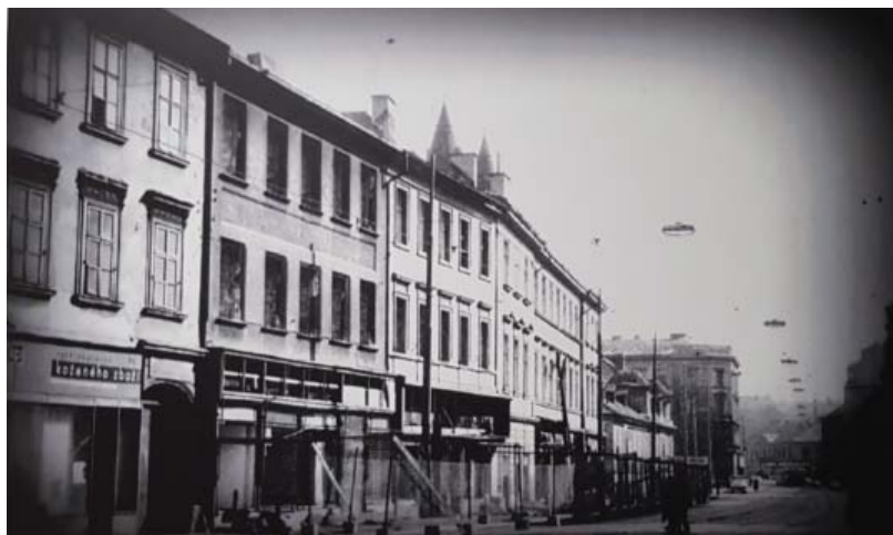
Štefánikova ulice před probouráním bloku
