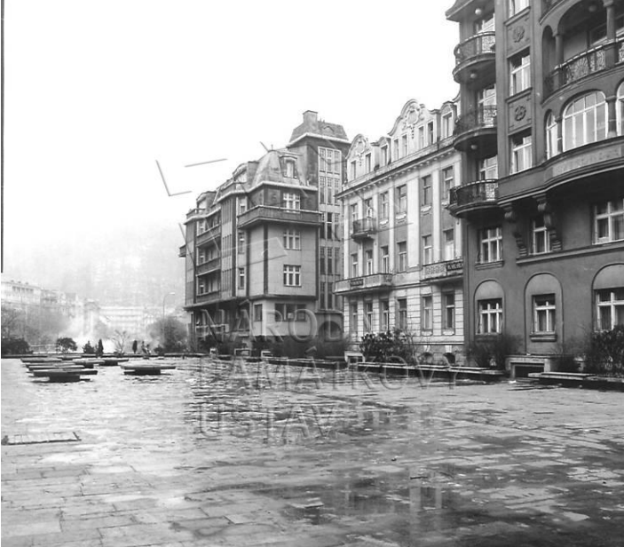
POHLED Z PLATFORMY NAD ŘEKOU STÁVAJÍCÍ KOLONÁDY, DŮM WOLKER, BÍLÝ LEV, ATLANTIC
