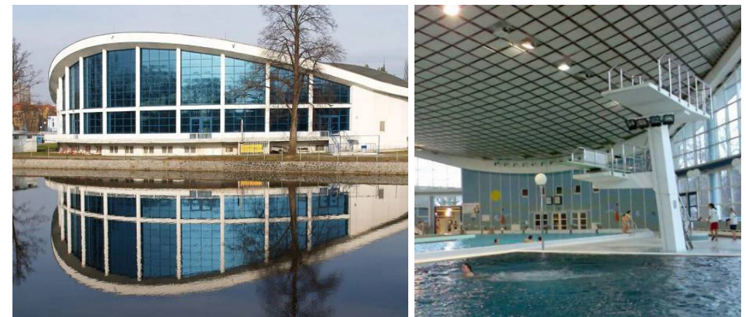
Plavecký bazén v Českých Budějovicích | Bohumil Böhm | 1971
