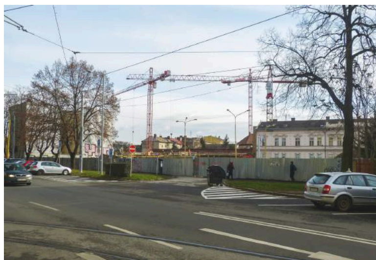
Hviezdoslavova ulica, pohľad cez prieluku na Továrenskú, v pozadí výstavba Mlynská bašta.
