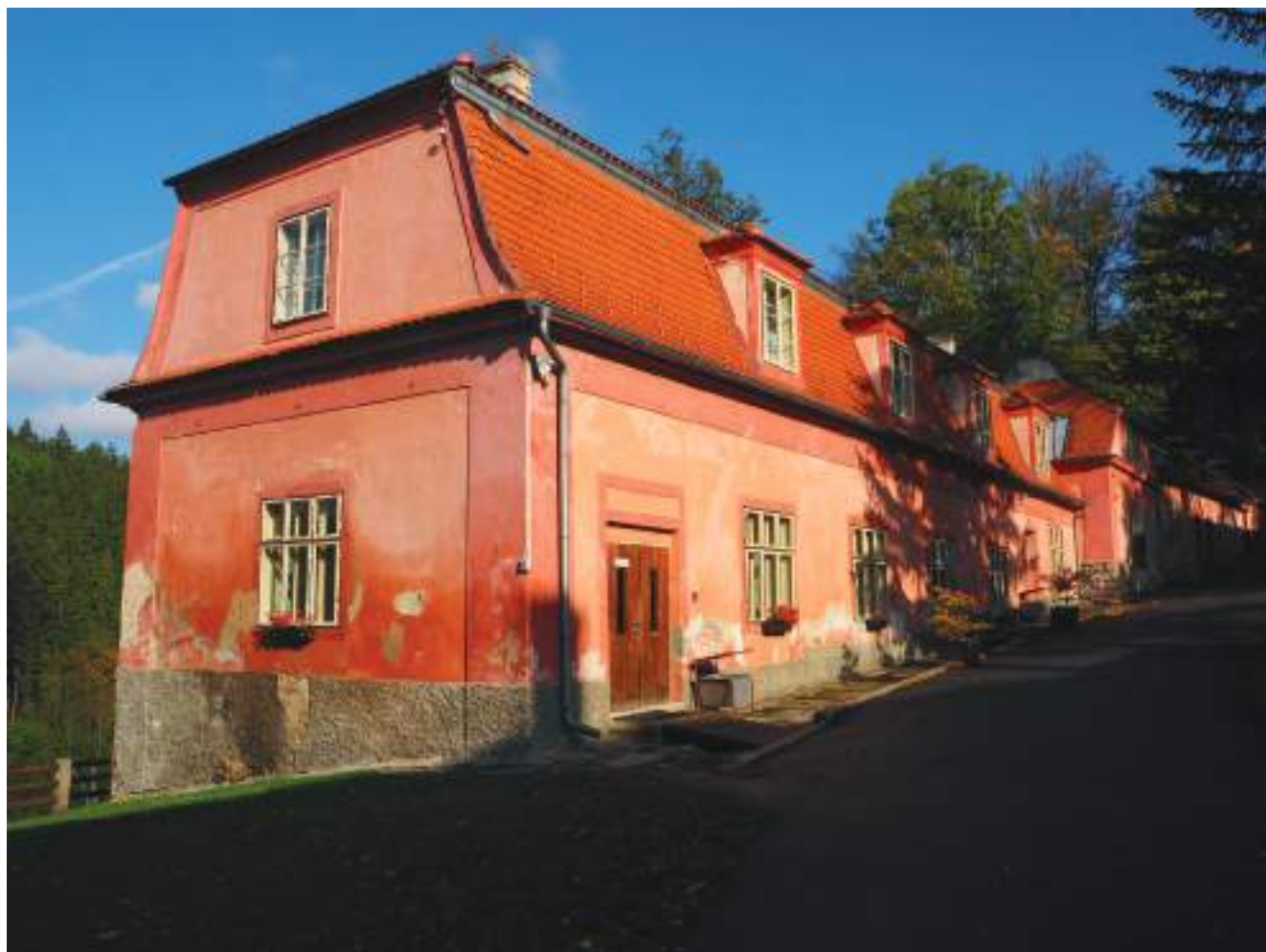
^ jižní část západní budovy hospodářského dvora s půdní vestavbou a dnešní jídelnou v přízemí (2019) [foto autor]
