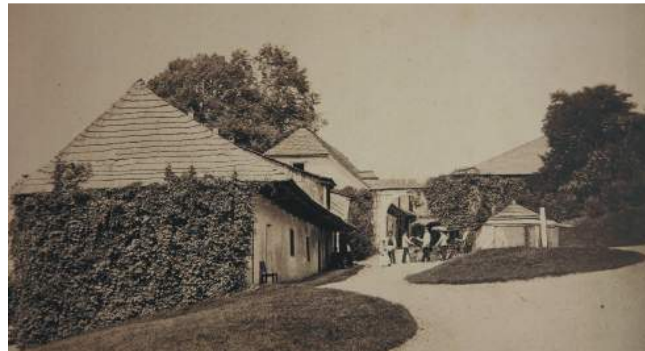
^ jižní část hospodářského dvora s branou, v popředí studna (1912?) [11]
