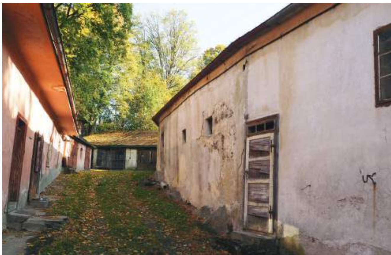
∨ severní část hospodářského dvora s původní kamennou dlažbou (2019) [foto autor]
