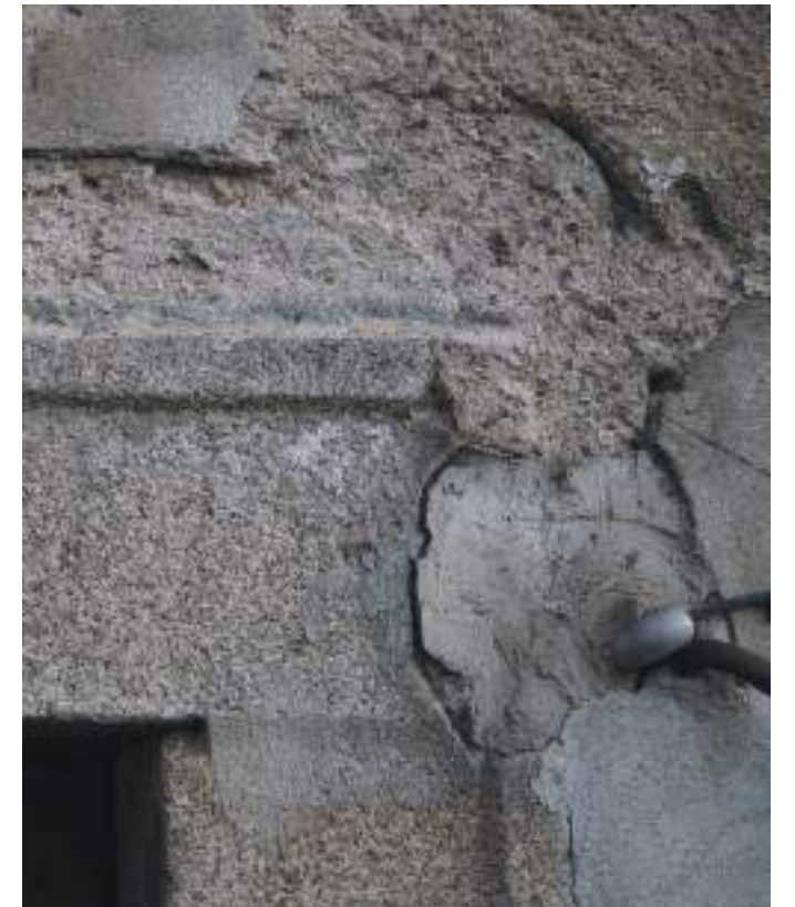
^ > ^ krajní části kamenného překlady, narušeného vedením elektroinstalace (2019) [foto autor]
