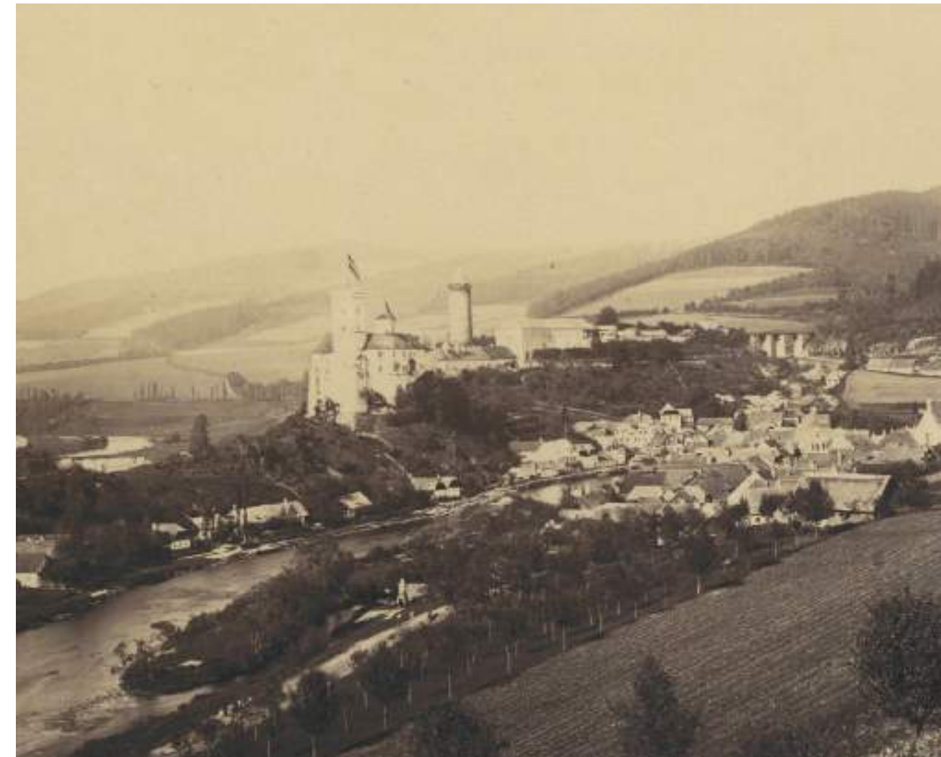
^ fotografie celého areálu i s městem (mezi 1857 a 1863) [II] Zachycuje ještě přízemní tzv. cottage se zámkem, ale již pokoje nad průjezdem. Dokládá tedy jejich výstavbu před navýšením tzv. cottage.
