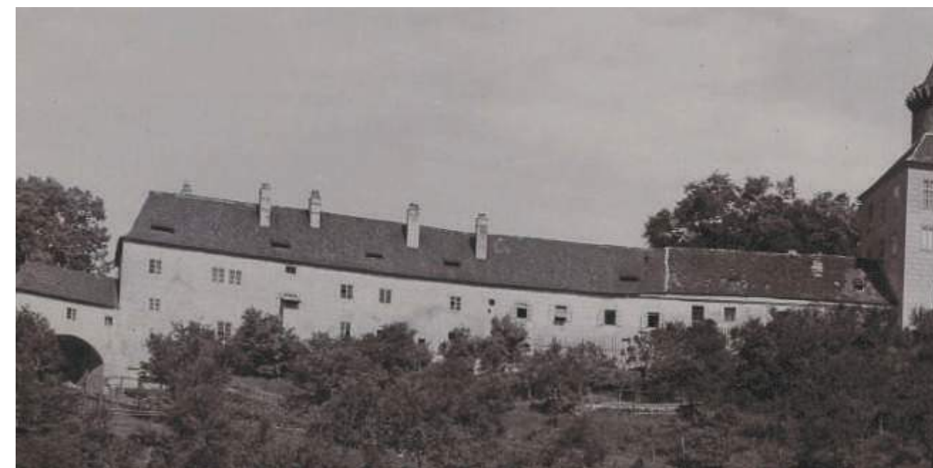
∨ jižní fasáda úřednické budovy (po 1863) [!]
