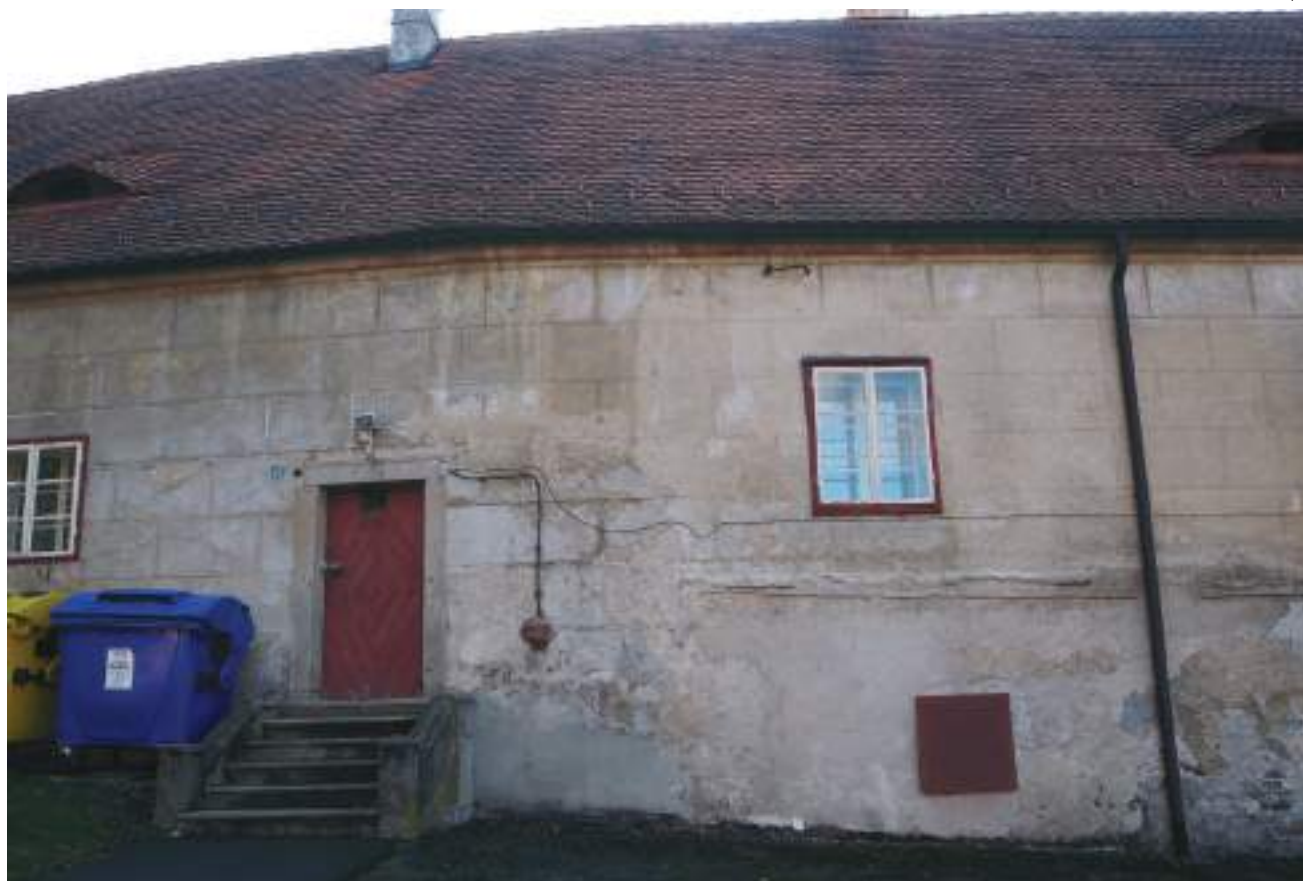
střední část severní fasády úřednické budovy (2019) [foto autor] v
