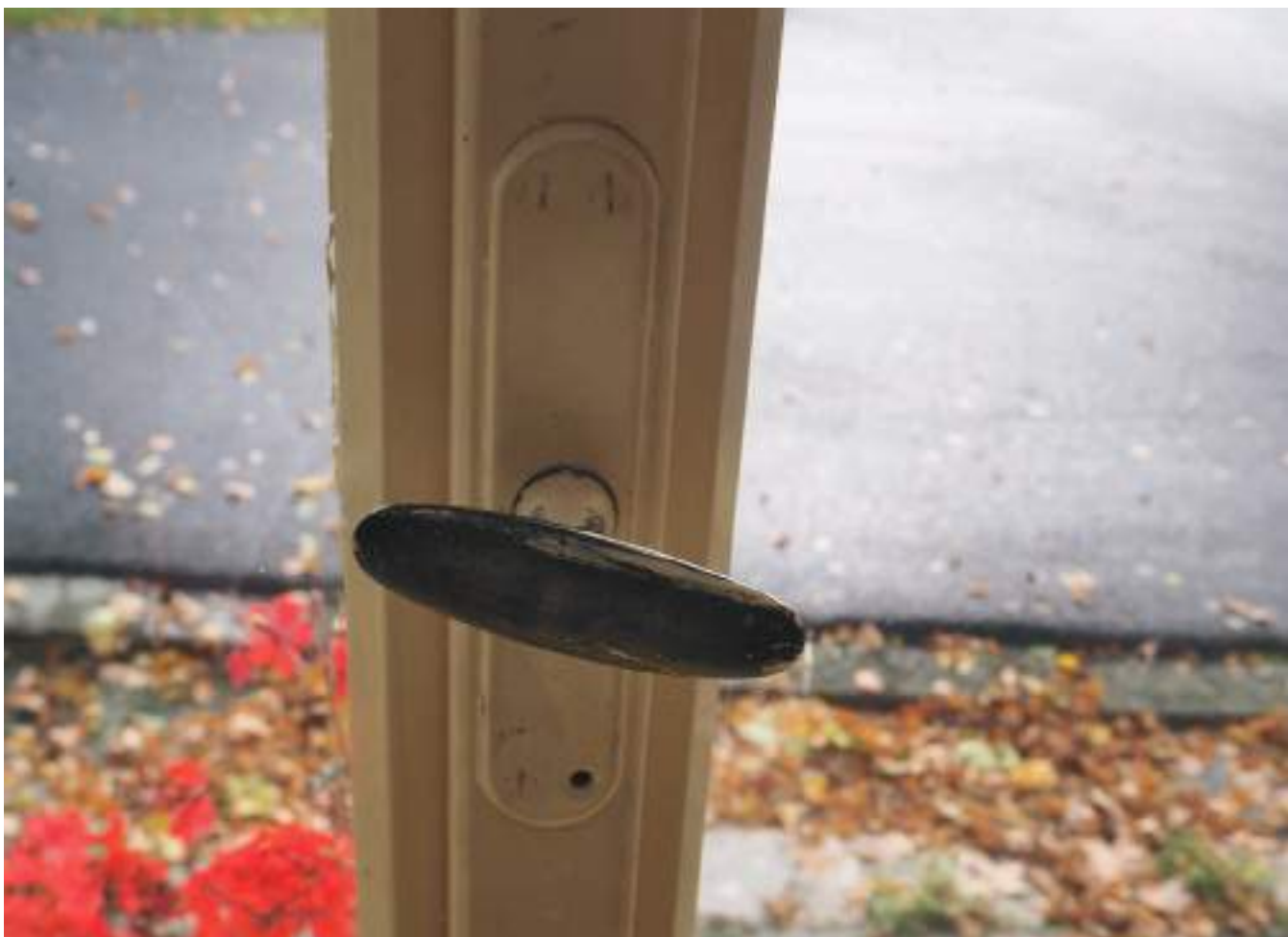
fotografie kování okna v přízemí v prostorech dnešní jídelny (2019) [foto autor] Obdobná kování byla používána ve 30. letech 20. století. v
