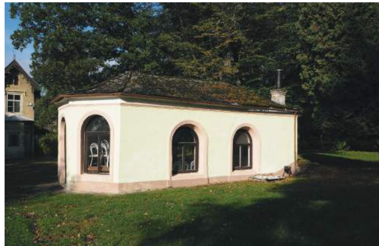
^ střední část bývalého salonu s patným komínem na vytápění zaniklých prosklených křídel (2019) [foto autor]
