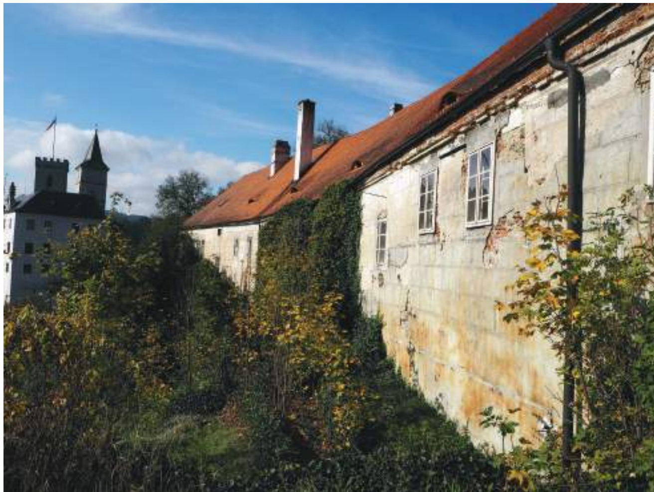
^ jižní fasáda úřednické budovy (2019) [foto autor]
