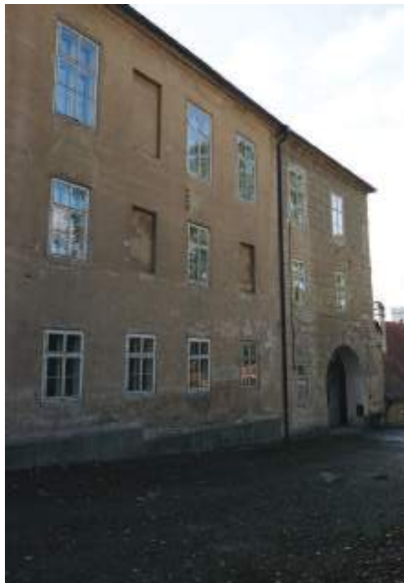
⤴ severní průčelí zám. budovy s průjezdem (2019) [foto autor]
