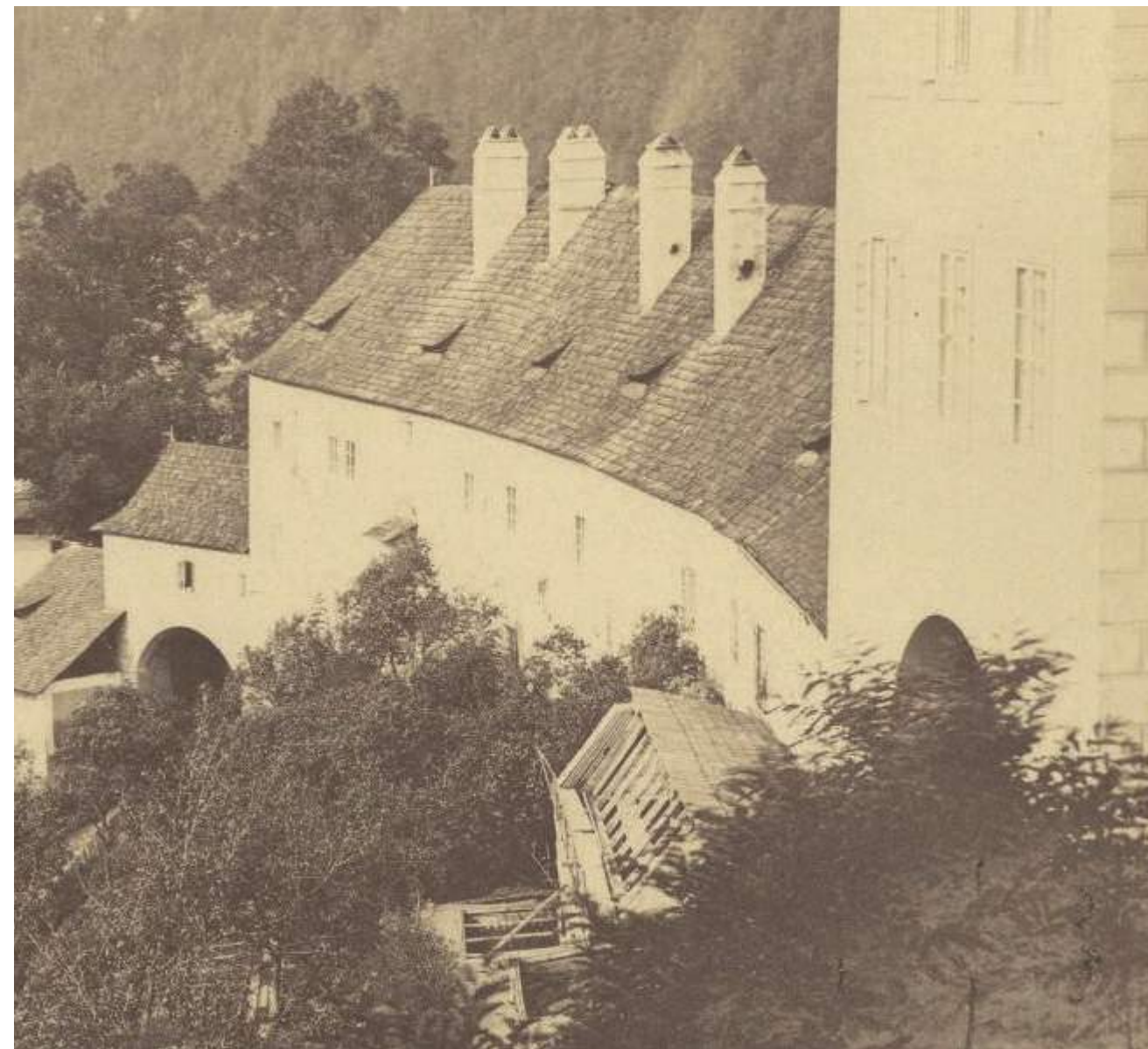
^ jižní fasáda úřednické budovy (1863?) [!]
