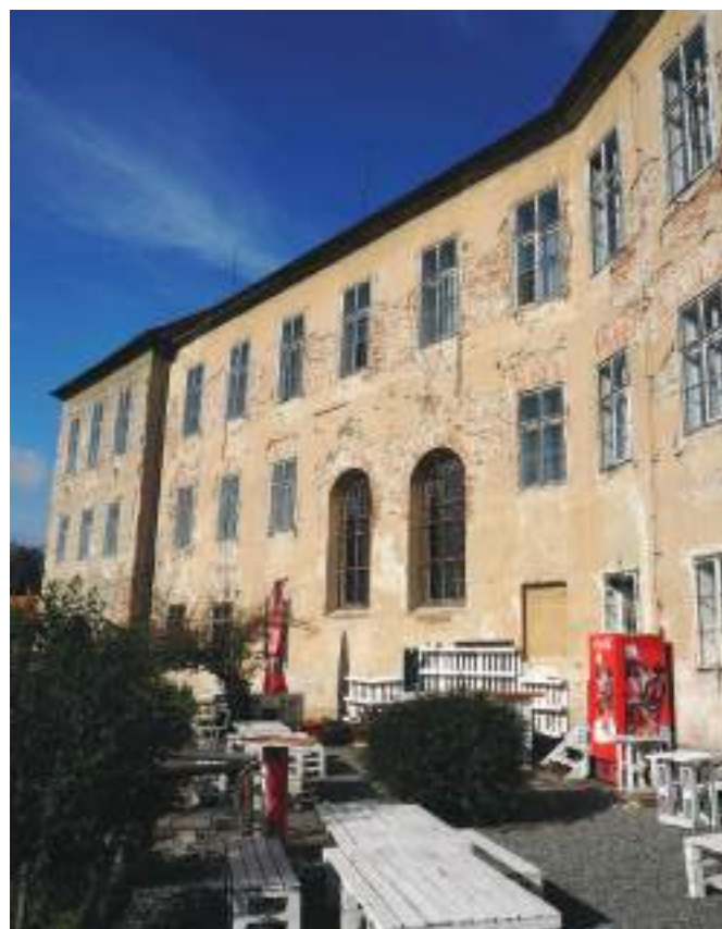
jížní průčelí zám. budovy (2019) [foto autor] ⤴
