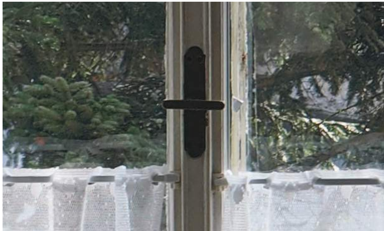
^ fotografie kování okna v podkrovní vestavbě (2019) [foto autor] Obdobná kování jsou datována kolem roku 1910.
