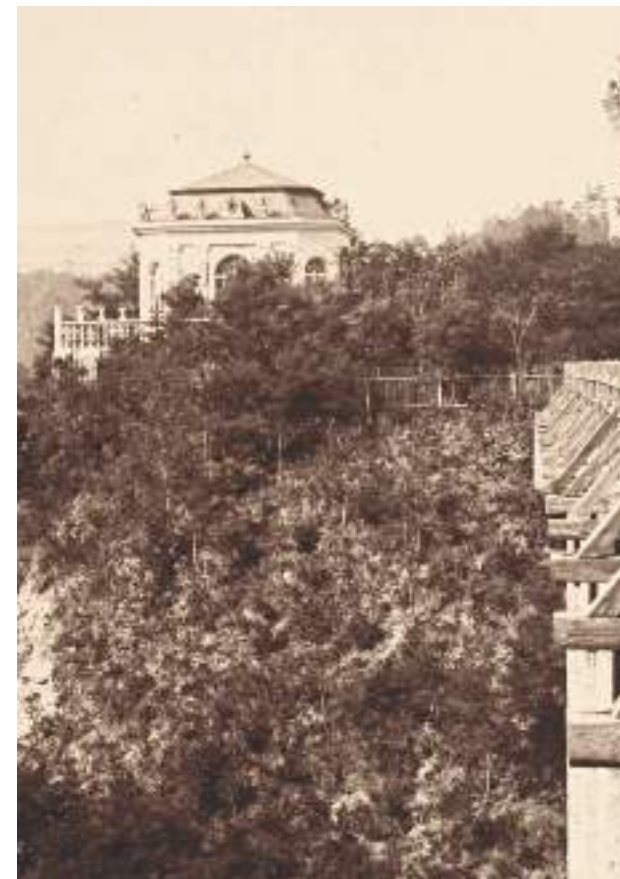
gloriét z východu z Vysokého mostu (po 1863) [1] ^
