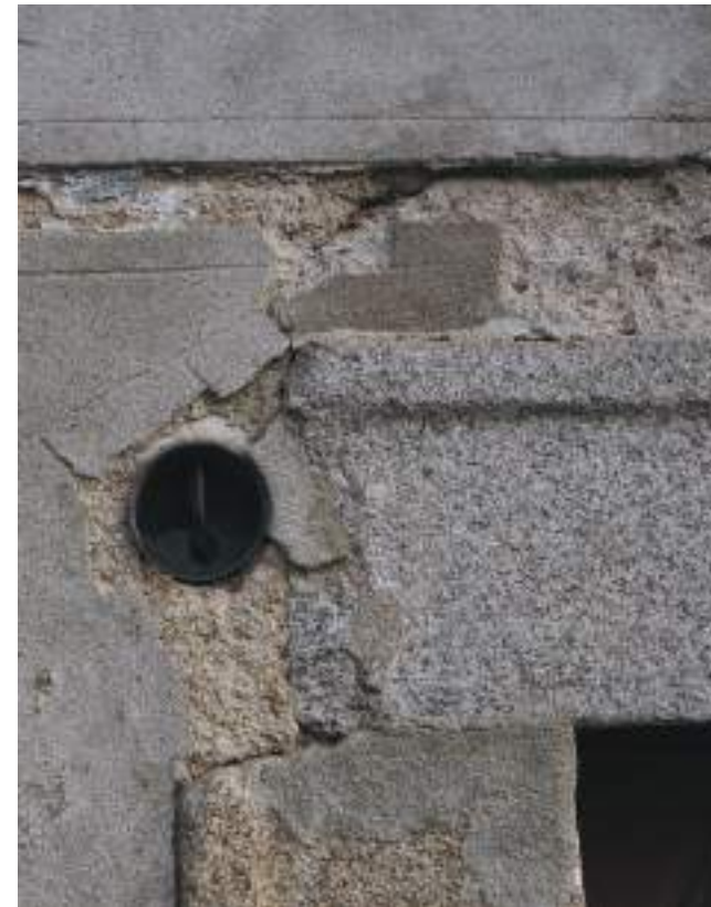
^ > ^ krajní části kamenného překlady, narušeného vedením elektroinstalace (2019) [foto autor]
