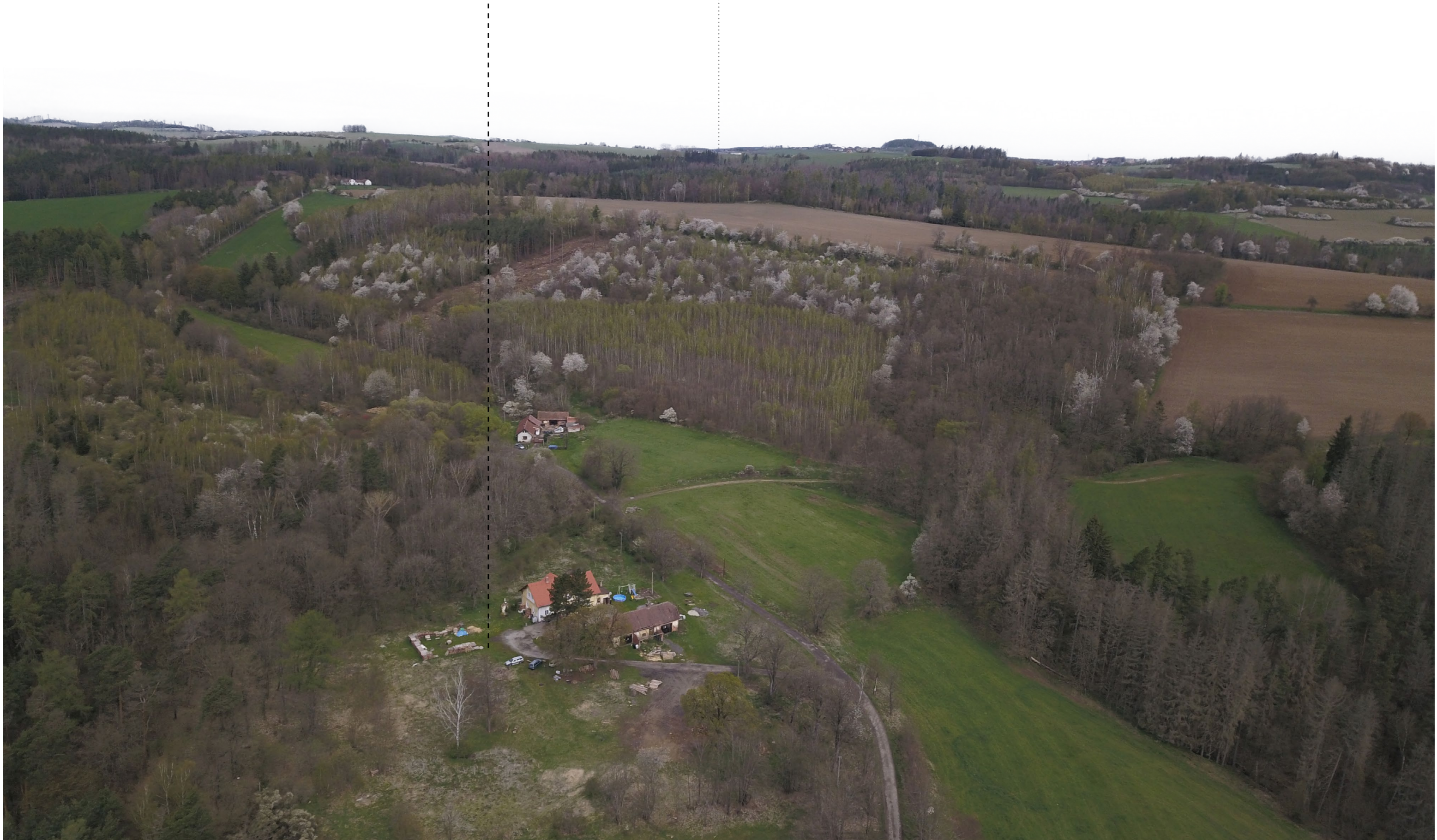
Vysoká Lhota pozemky a budovy
