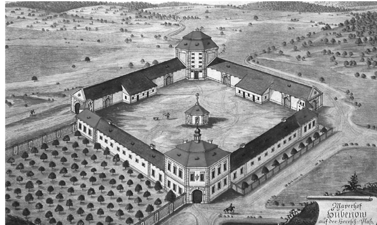
dvůr Hubenov, architekt J.A.Santini
