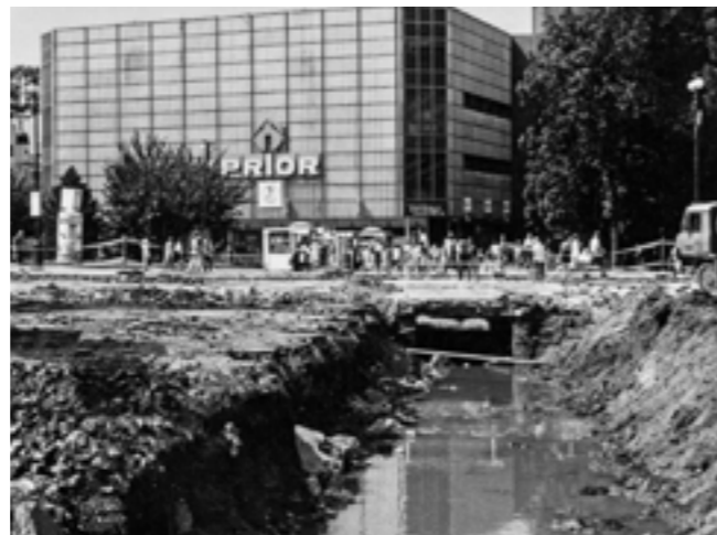
1975 Odkrytie potoku Všívák pri výstavbe OD Prior
