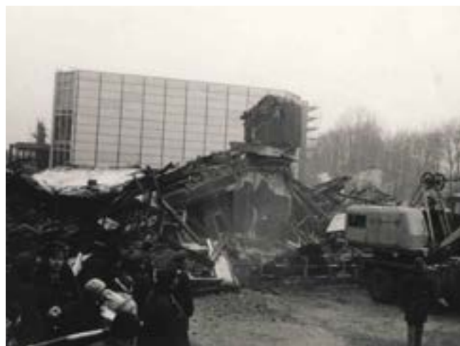
1970 Demolícia pôvodnej zástavby pri Hlinkovom námestí
