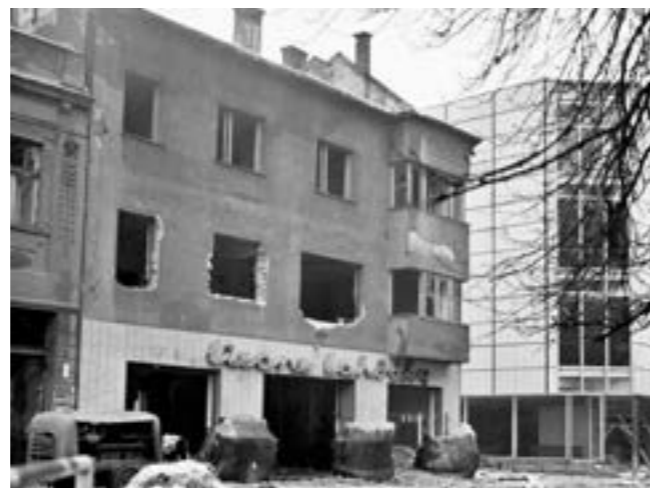
1975 Demolícia bývalých „Lahôdok“ pri Braunovom dome
