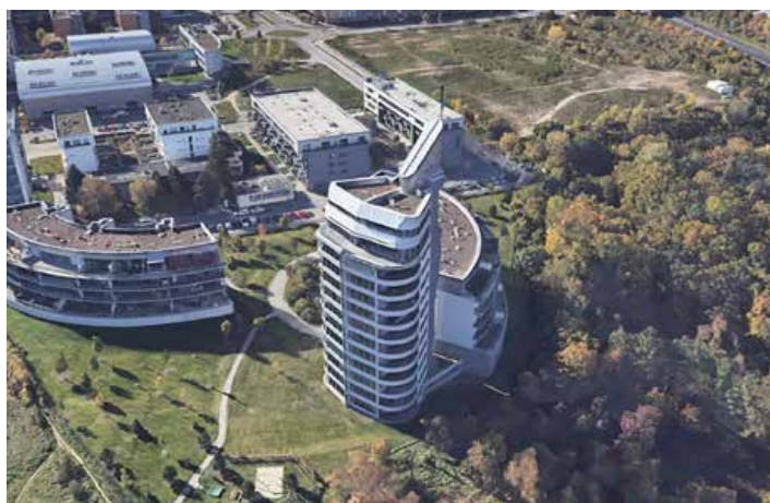
Obytná věž Bohunice
