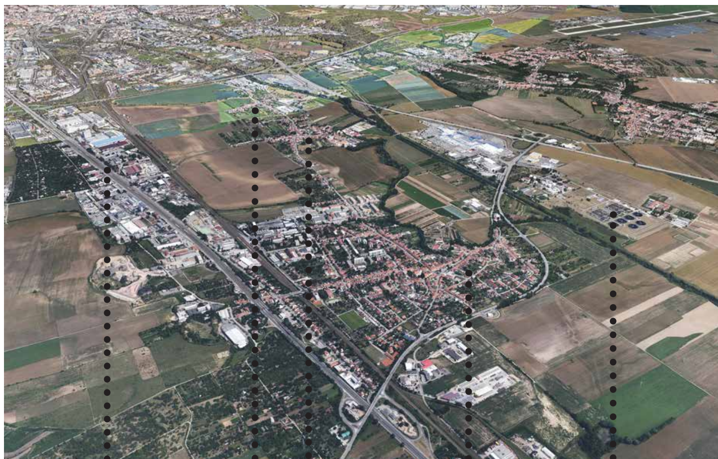
Dálnice D52 D. Heršpice Přízřenice Modřice ČOV
