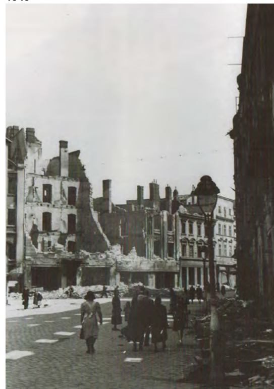
Trosky domů v ulici Mezi trhy
