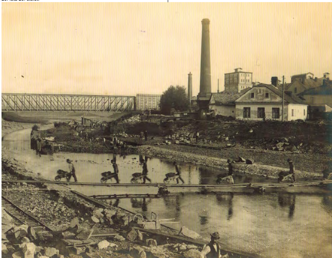
Regulační práce na řece Opavě
