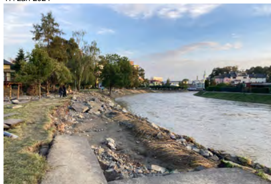
Hozovo nábeží, v pozadí napravo kostel sv. Vojtěcha na Dolním náměstí
