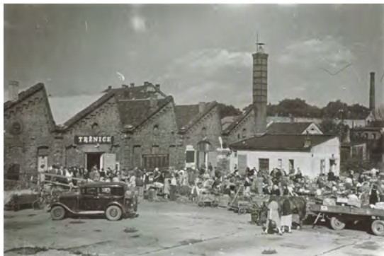
Městská tržnice na Nákladní ulici
