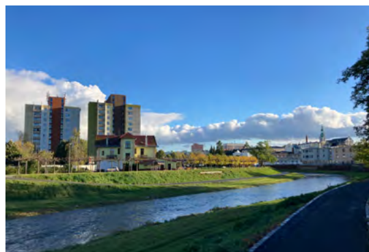
panorama koryta řeky se sídlištěm Kateřinky a kostelem sv. Vojtěcha na Doním náměstí - městská část
