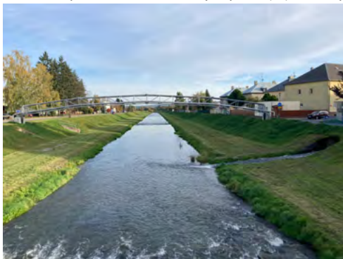
Pohled z lávky v industriální části - směr jihovýchod - po proudu řeky
