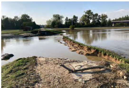
Val cyklostezky směr Palhanec - vylité koryto řeky - napravo dopravní most městského obchvatu
