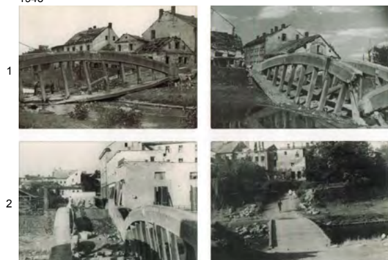
1, 2, 3 - ruiny mostu na Černé ulici 4 - prostor mostu upravený pro průjezd vozidel
