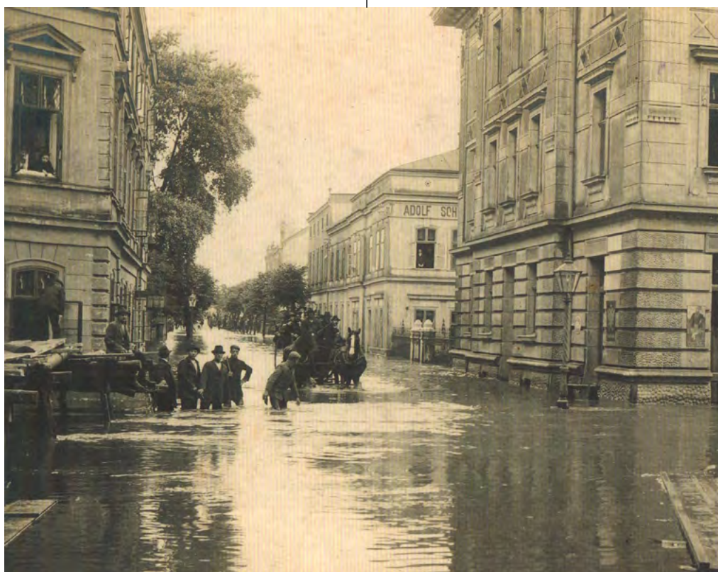
Křížení ulic Pekařská a Nákladní, pohled z Pekařské ulice směrem k řece Opavě
