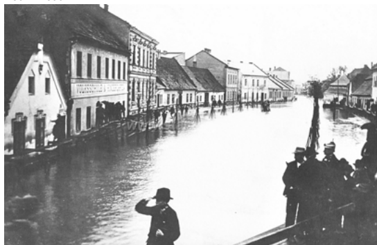
Ratibořská ulice při povodni v roce 1897 nebo 1899. Jedná se o místo přibližně dnešní křižovatky ulic Partyzánská, Holasická a Ratibořská. zdroj: 4
