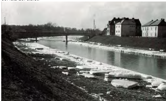
Betonový most na Mostní ulici
