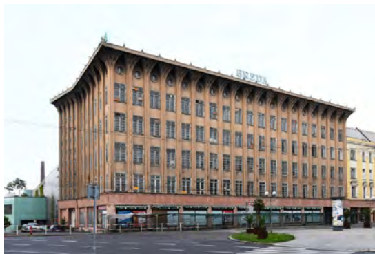
Stará budova Obchodního domu Breda&Weinstein
