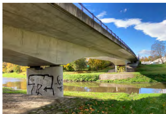
most dopravní infrastruktury - parkově-rekreační část, u Stříbrného jezera
