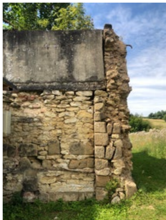
betonová nádrž cca z pol. 40. let
