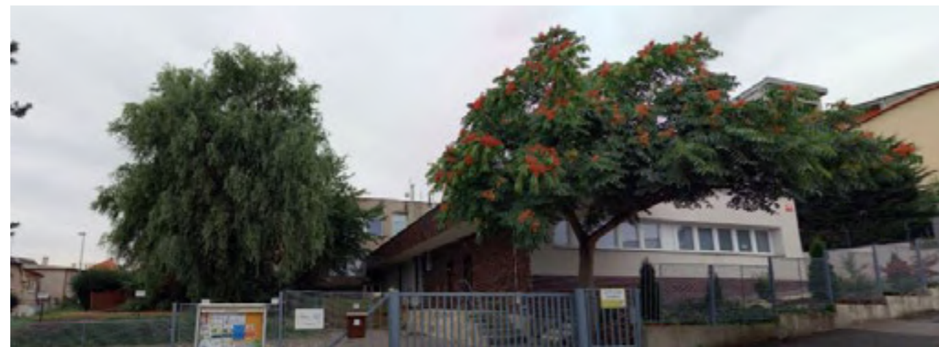
Recovery house Praha, Lehovce, v budoově bývalého chráněného bydlení
