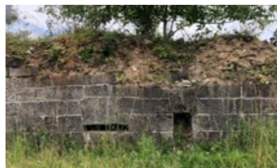
světlík do sklepa ze severní zdi
