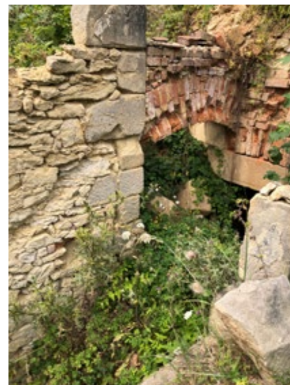
otisk schodiště a podesty nad vstupem do sklepa
