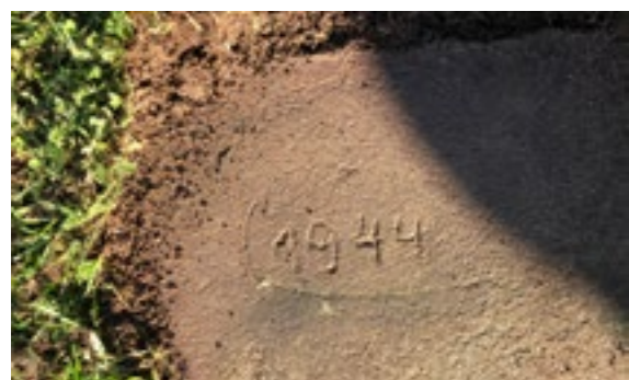
datace betonového mlatu zednickou lžící
