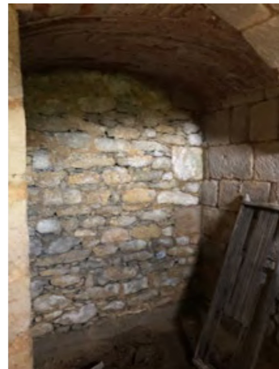
sklep pod hlavní obytnou budovou
