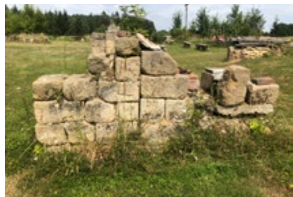
kamenný pilíř s ozubem na vrata
