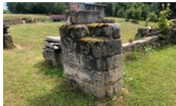
kamenný pilíř s ozubem na vrata
