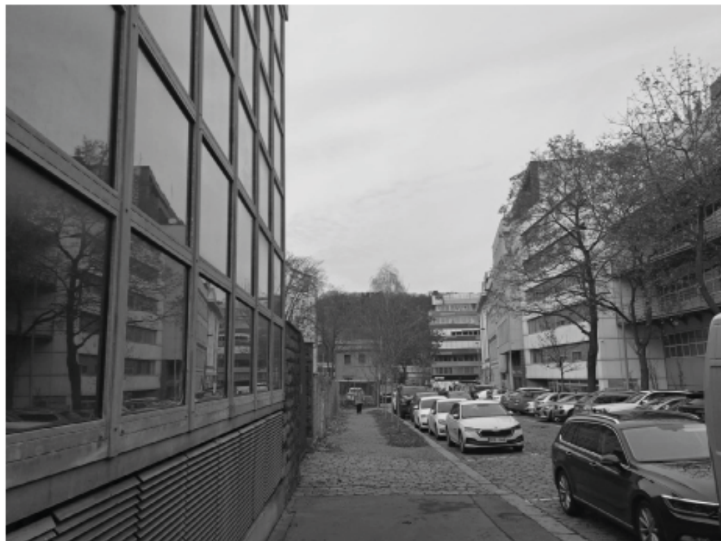
nová aktivní trafostanice PRE
