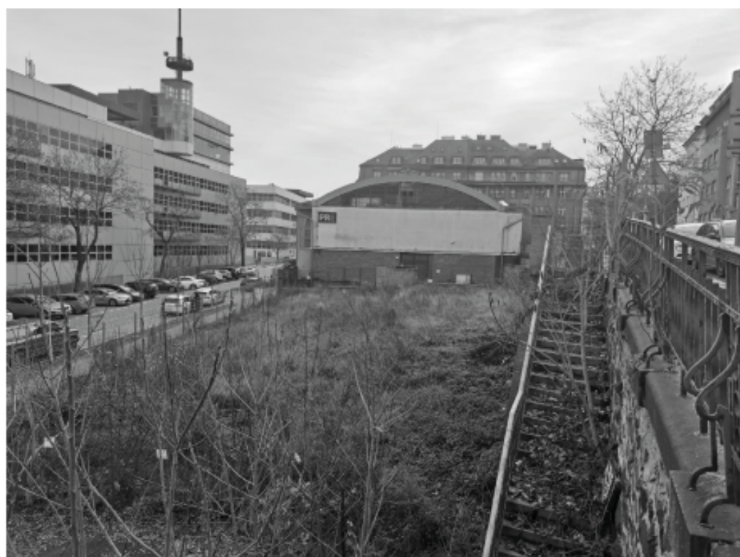
řešené území s trafostanicí PRE
