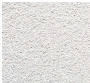
Stěny a stropy
